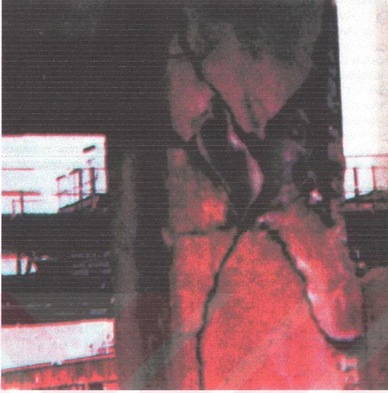
Resim 1.2 Mekanik etkilerle bozulmuş kolon
