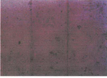
Normal bir beton yüzeyin görünüşü
