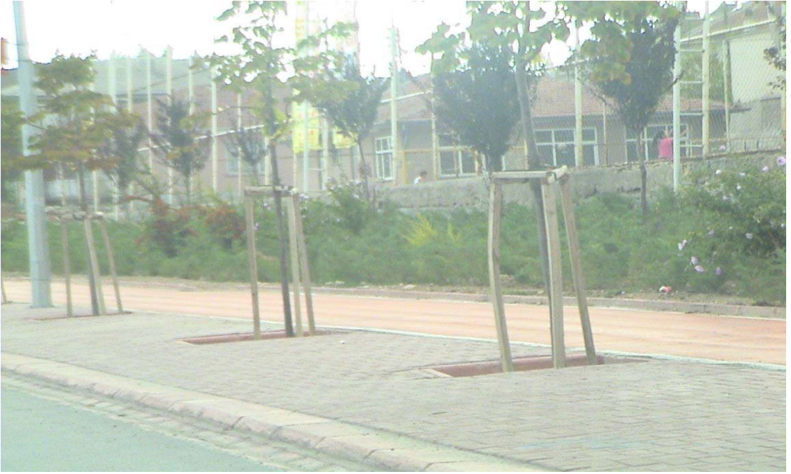
Resim 3.13. Beyşehir çevre yolu bisiklet yolundan görünüm
