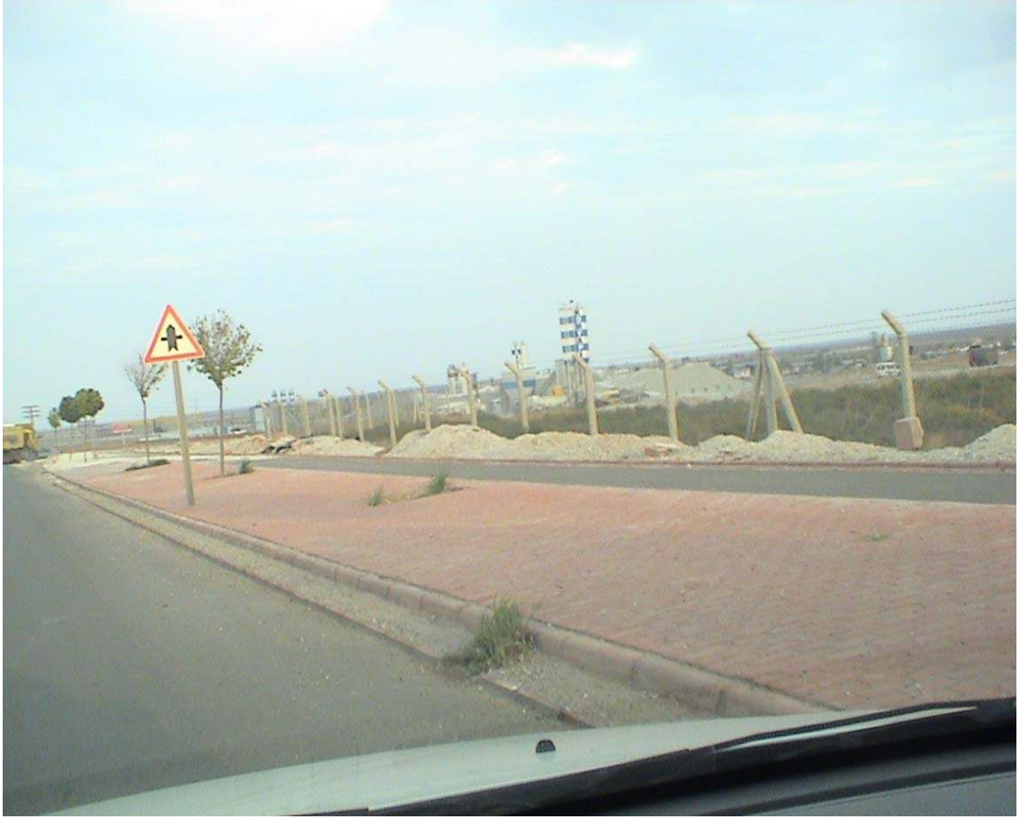
Resim 3.16. Aliya İzzetbegoviç Bulvarı bisiklet yolundan görünüm
