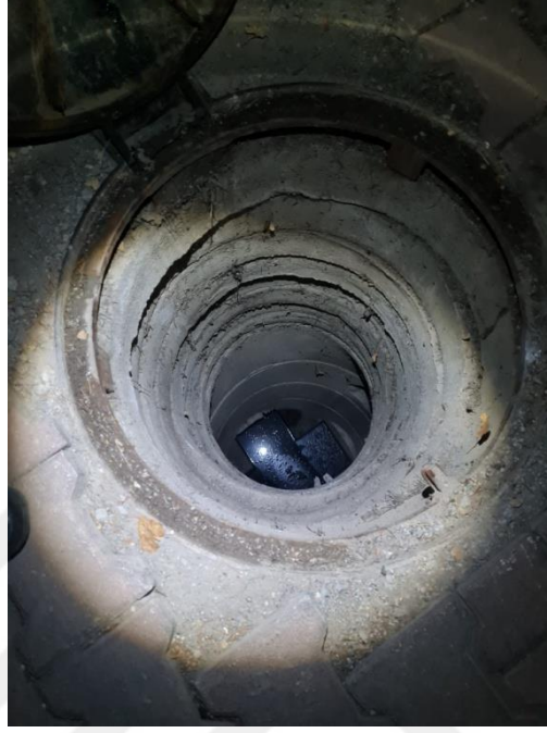
Şekil 3.2. Numune alma bacası
