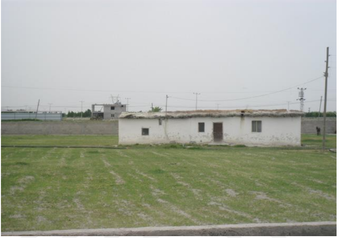
Fotoğraf 13: Ereğli İlçesi Adabağ Mahallesi'nde Kerpiç Ev
