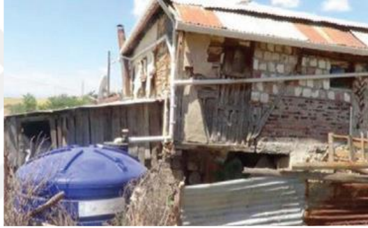
Şekil 2.44. Ankara Tekke Kuyumcu Köyü Yağmur Suyu Hasadı (YHD, 2022)
