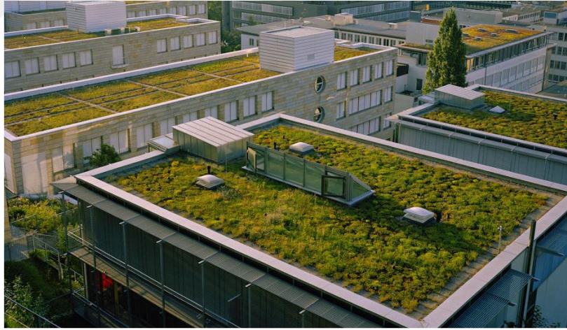
Şekil 2.6. Yeşil çatı uygulaması (DSİ, 2017)
