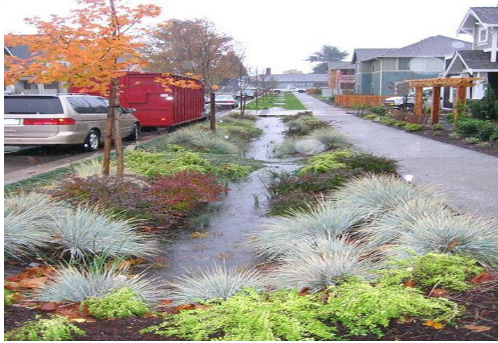
Şekil 2.17. Yağmursuyu hasadı örneği (Doğru, 2023)
