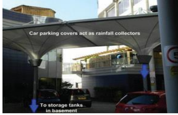
Şekil 2.34. Londra'daki Rafayel Hotel'den yağış toplama ve depolama sistemi (YHD, 2022)
