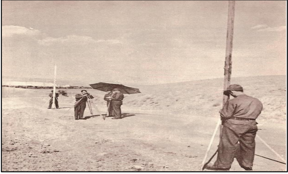
Şekil 4.2. 1960 yılında gerçekleştirilen birinci derece nivelman çalışmaları (Türkezer vd., 2011).
