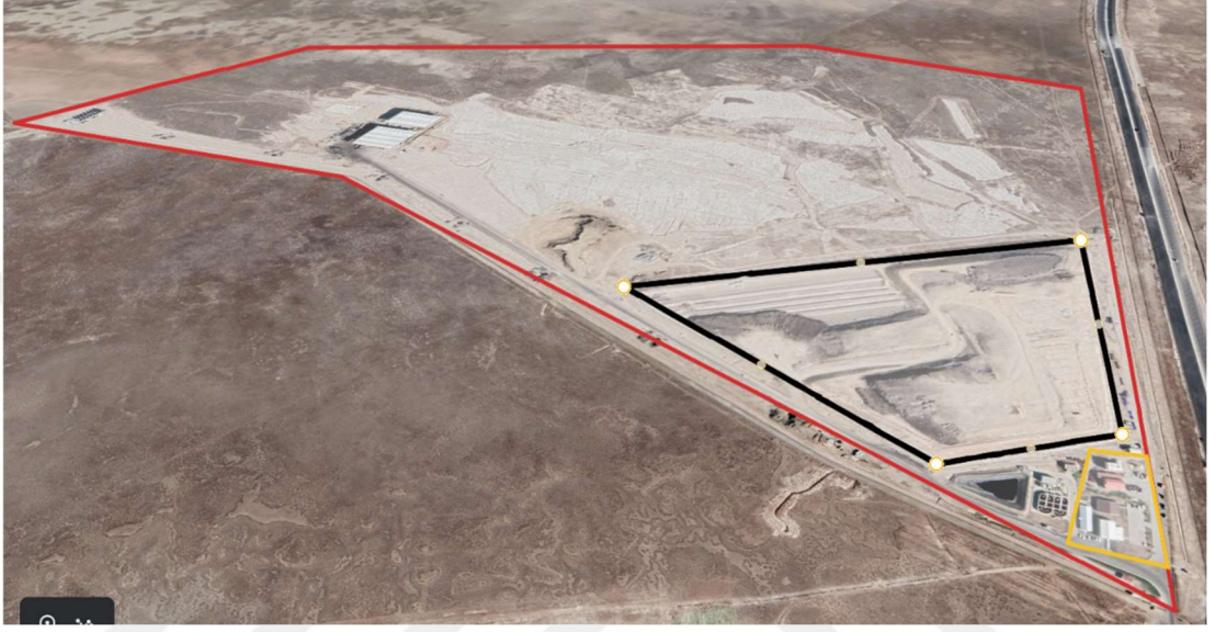
Şekil 3.1. Konya entegre katı atık sahası uydu görüntüsü.
