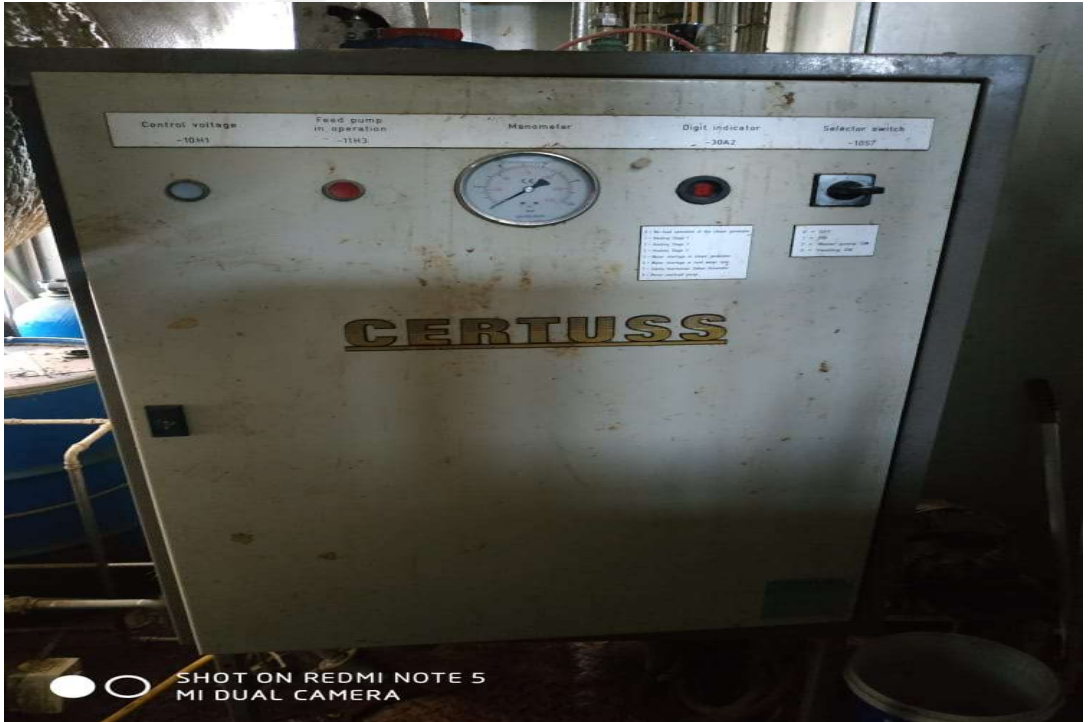
Şekil 4.16. Logmed GT500 makine elektrikli buhar jeneratörü.
