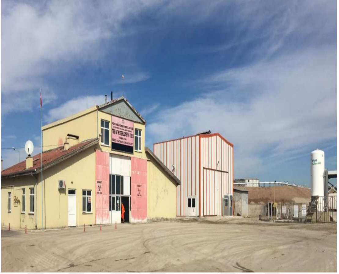
Şekil 4.6. Konya Tıbbi Atık Sterilizasyon Tesisi.
