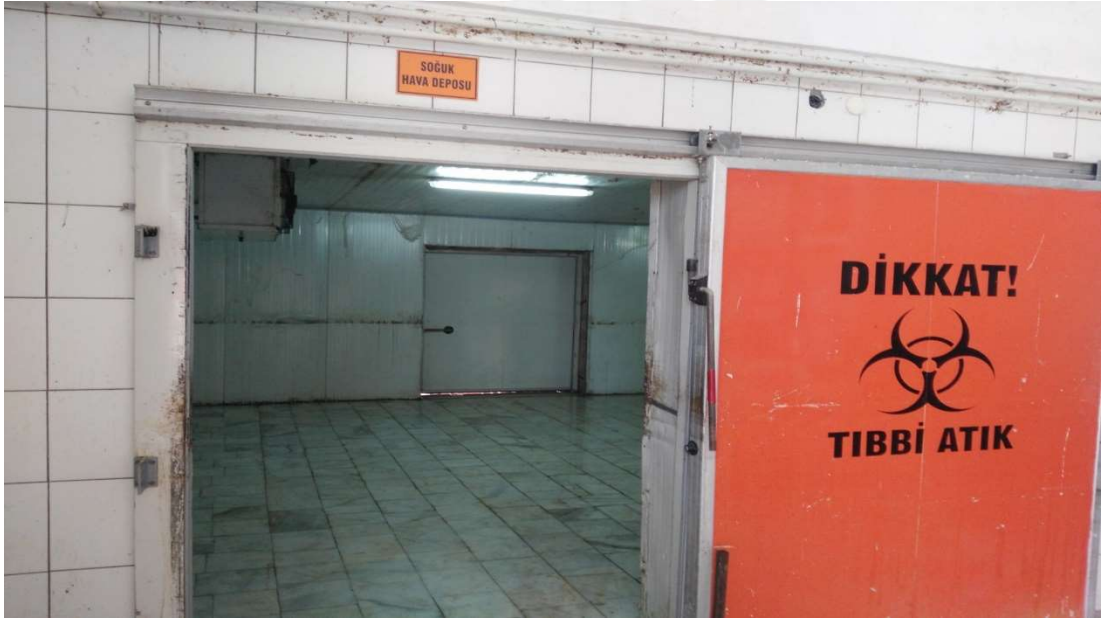
Şekil 2.7. Tıbbi atık geçici depolama alanı.
