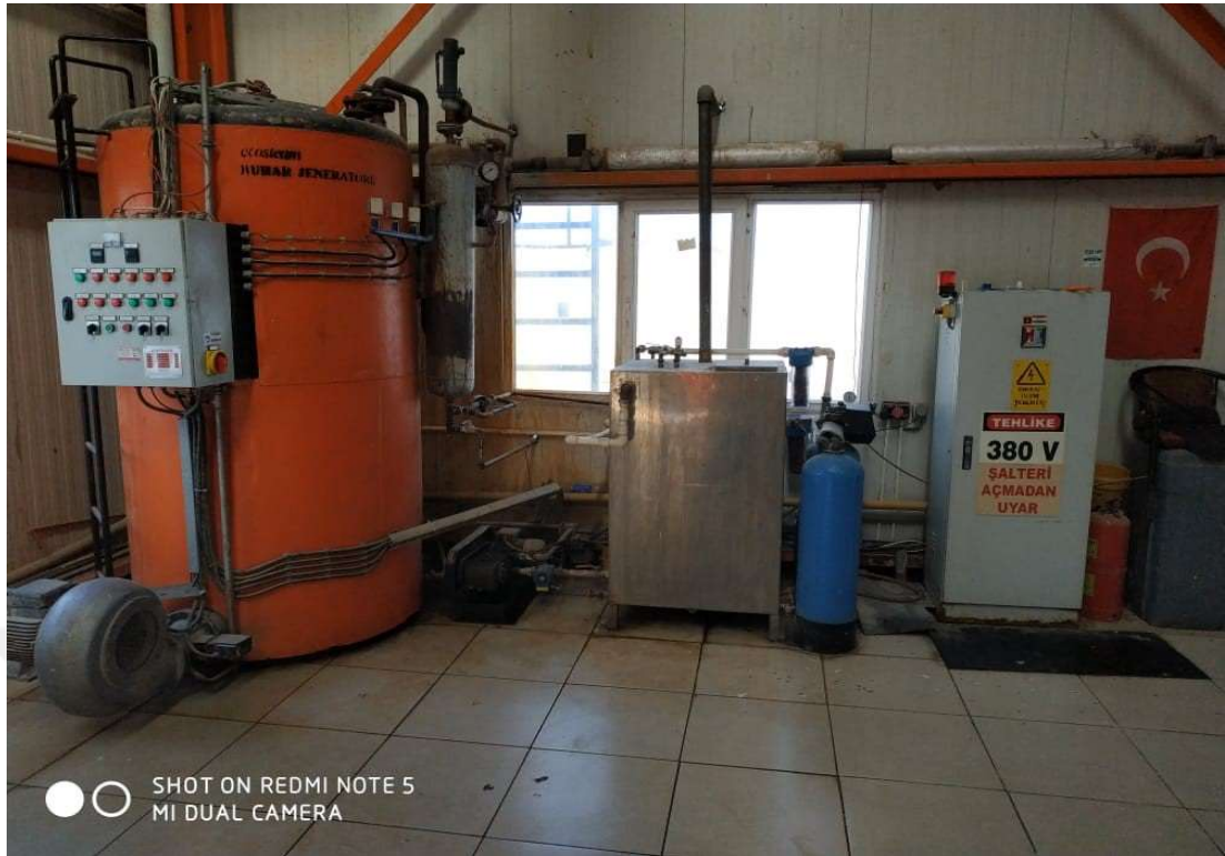
Şekil 4.20. Akar 750L makine buhar jeneratörü ve su yumuşatma ünitesi.
