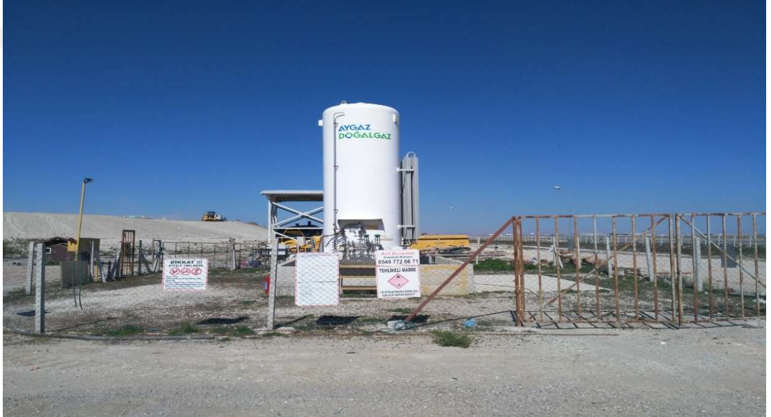
Şekil 4.12. LNG tank alanı.
