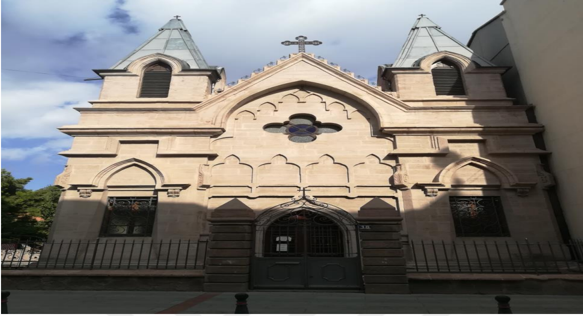
Resim 128: Konya Aziz Pavlus Kilisesi Dıştan Görünüm
