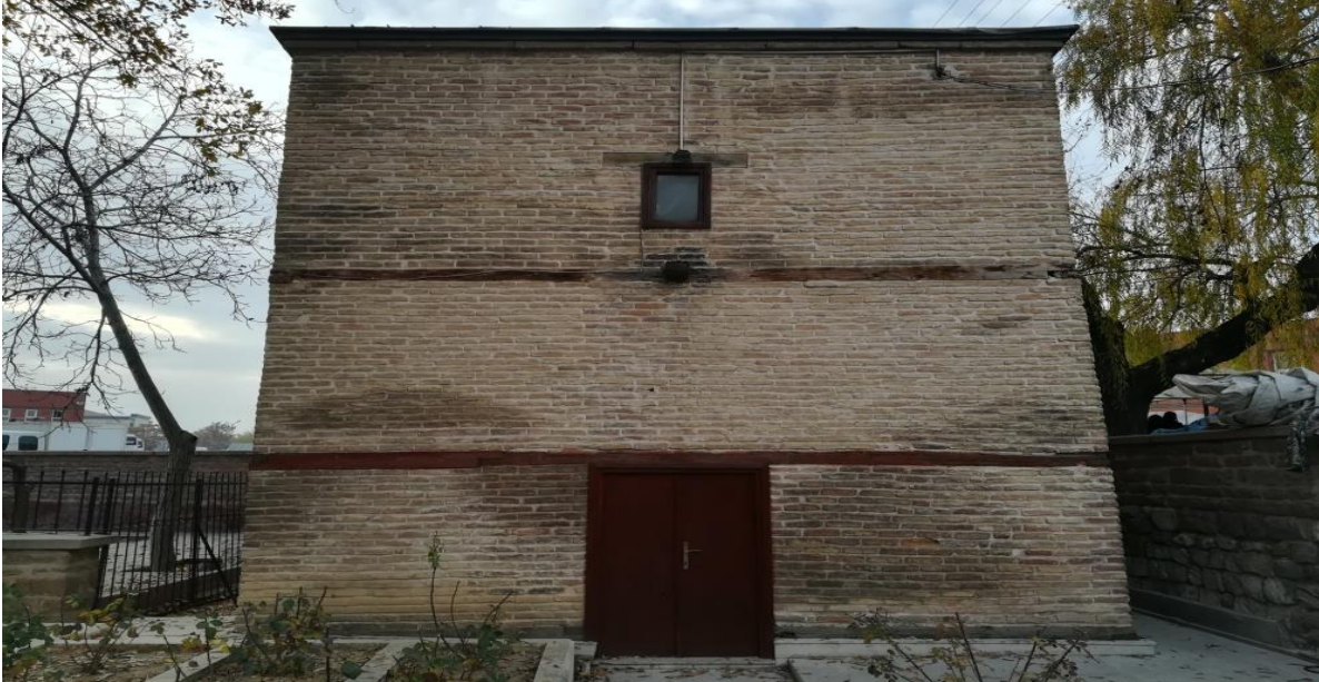
Resim 47: Pir Esad Sultan (Pisili) Türbesi Dıştan Görünüm
