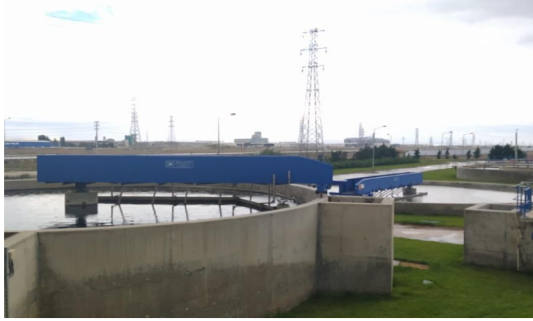
Şekil 3. 13. KOS AAT'ye ait kimyasal ve biyolojik çökeltme havuzları
