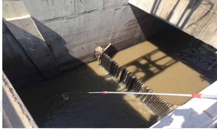
Şekil 3. 2. Konya Kentsel AAT giriş yapısı
