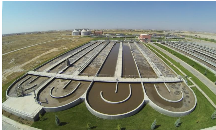
Şekil 3. 3. Konya Kentsel AAT havalandırma havuzu ünitesi
