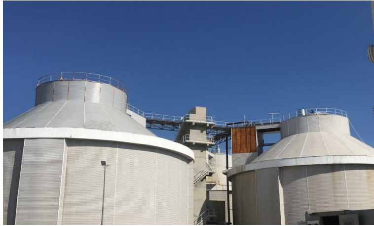
Şekil 3. 5. Konya Kentsel AAT çamur çürütme tankları
