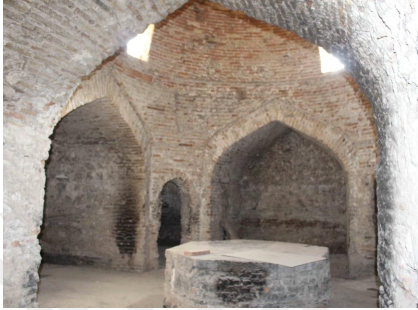
Şekil 2.29. Ahmet Efendi Hamamı'nın iç mekandaki sıva raspası işlemi (Akıl, 2020)
