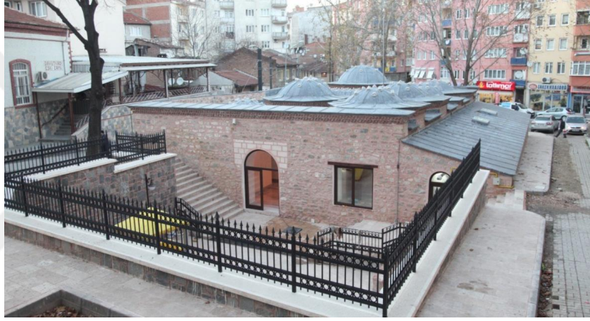
Şekil 3.11. Bursa Muallimzade Hamamı restorasyon sonrası fotoğrafı (URL-23, 2020)
