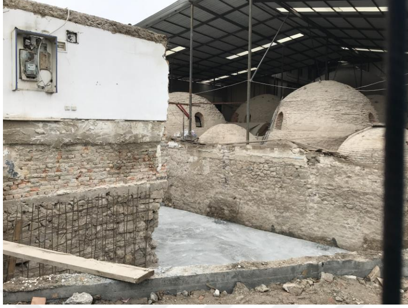
Şekil 2.30. Ahmet Efendi Hamamı'na yapılacak ek yapının zemin döşemesi (Akıl, 2020)
