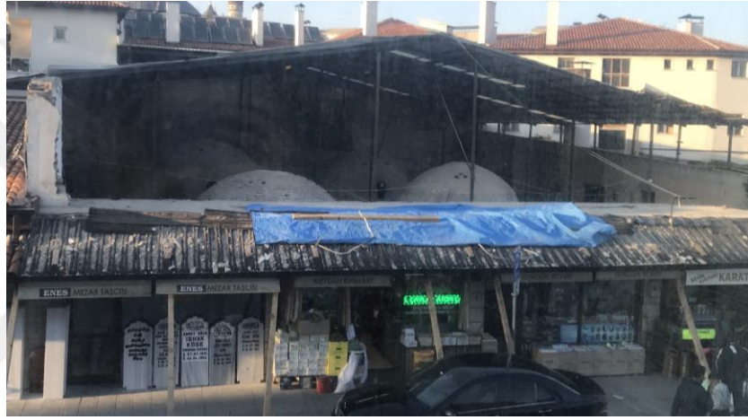
Şekil 2.27. Ahmet Efendi Hamamı restorasyon ve yıkım çalışmaları (Akıl, 2020)
