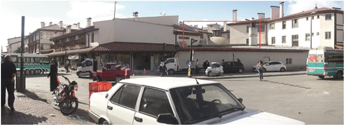
Şekil 2.11. Hamamın güneydoğu cephesi ve erkekler sıcaklık kubbesi (Akıl, 2016)
