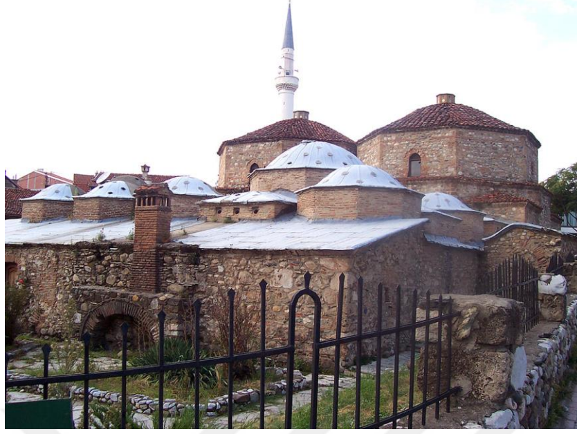
Şekil 3.6. Gazi Mehmet Paşa Hamamı restorasyon öncesi çekilmiş bir fotoğraf, Kosova (URL-16, 2020)
