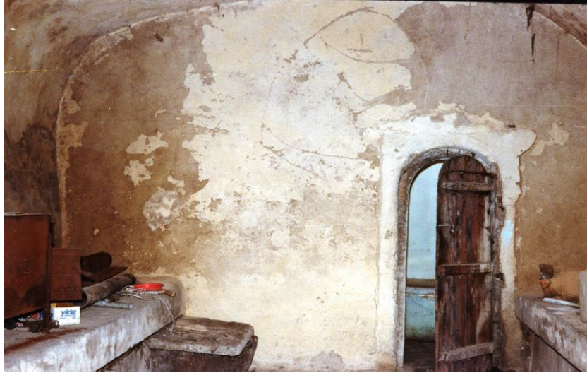
Şekil 2.23. Debbağ Hamamı'nın iç mekan fotoğrafı (KVBM, 1985)
