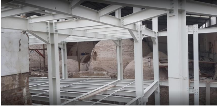
Şekil 2. 32. Ahmet Efendi Hamamı'na yapılan çelik ek yapı (Akıl, 2020)
