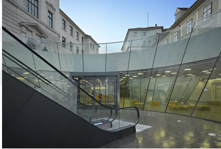
Şekil 3.22. Yer altında yapılan ekler - Avusturya, Graz, Joanneum Müzesi Ek Binası (URL-48, 2020)
