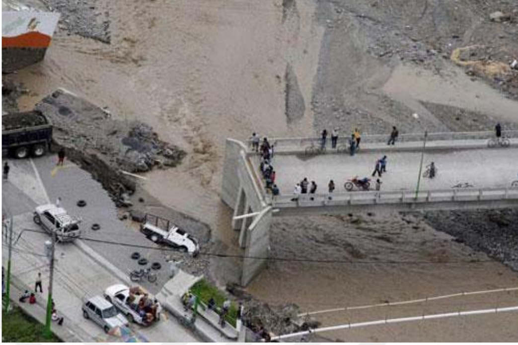
Şekil 3.5. Kanat duvarı ayağı için oyulma türü C örneği (Terry vd., 2011).
