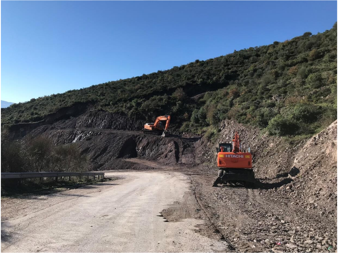
Şekil 17: Hacı Osman Mahallesi Kuzeyinde Yol Geniştirme Çalışması (25.12.2017)
