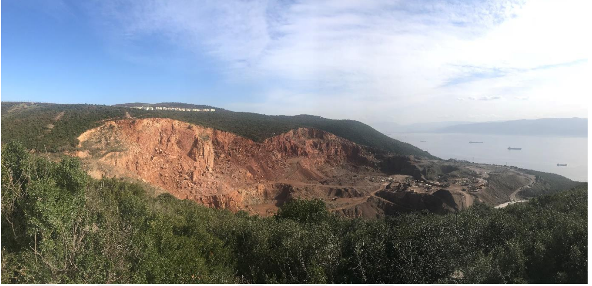
Şekil 16: Agah Ateş Mahallesi Doğusundaki Taş Ocağı (09.02.2018)
