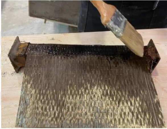
Şekil 3.32. Birinci kat güçlendirme uygulaması (BFRP)
