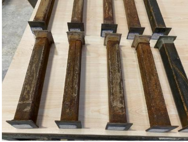
Şekil 3.29. Korozyona uğramış profillerin güçlendirilmeden öncesi
