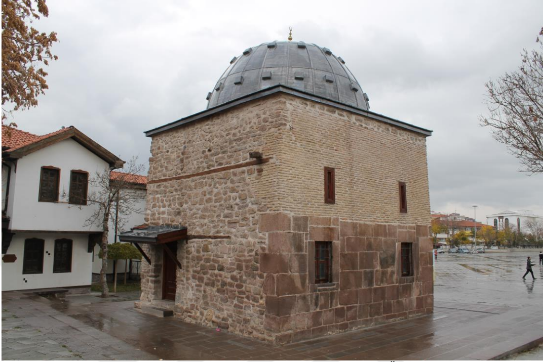
Fotoğraf 1.4. Şifâhâne Mescidi batı cephesi (Ünal, 2023)
