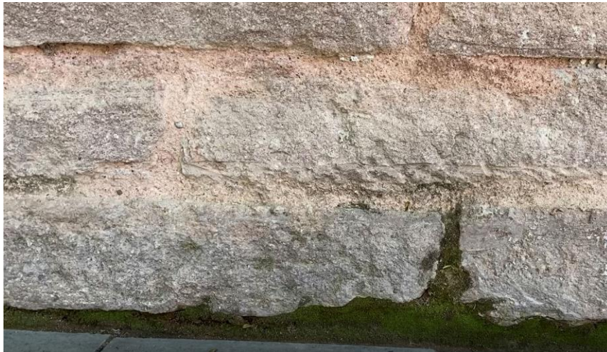
Fotoğraf 2.22. Konya Alâeddin Cami yapı malzemesinde tespit edilen yosunlar (Ünal, 2023)
