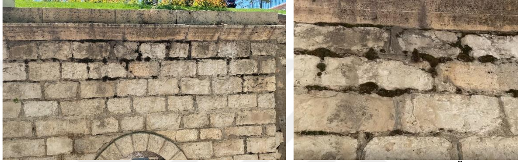
Fotoğraf 2.23. Konya Alâeddin Cami yapı malzemesinde gözlemlenen mantarlar (Ünal, 2023)
