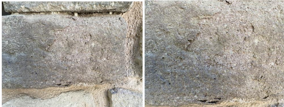
Fotoğraf 2.3. Beşâre Bey Mescidindeki taşta gözlemlenen kabarma (Ünal, 2023)
