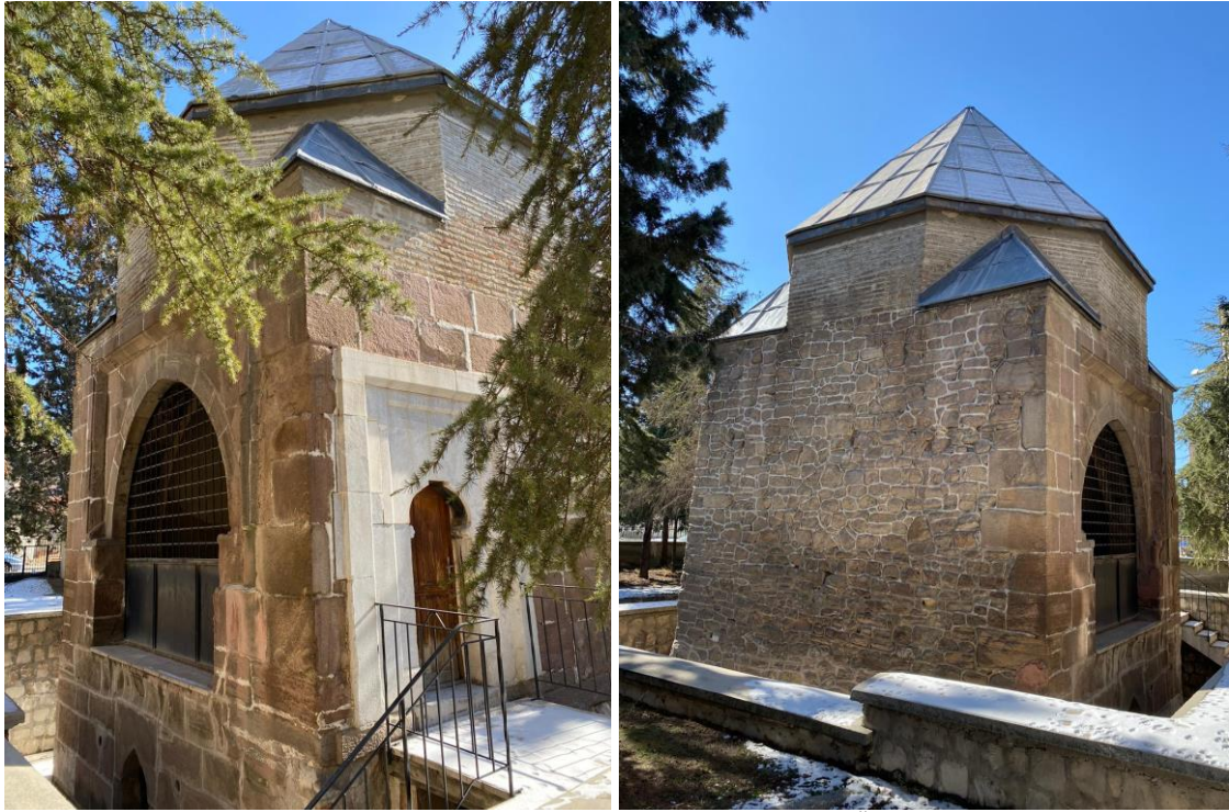
Fotoğraf 4.6. Şeyh Osman Rûmî Türbesi fotoğrafı (Ünal, 2023)
