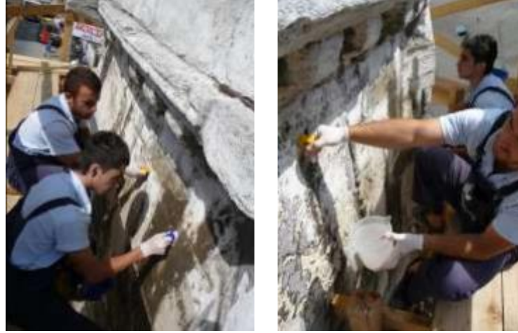
Fotoğraf 3.6. Kirli yüzeylerin fırça ve su ile temizlenmesi (MEB, 2013)
