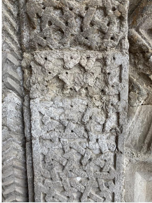
Fotoğraf 2.8. Sırçalı Medrese taş kapısında tespit edilen dağılmalar (Ünal, 2023)
