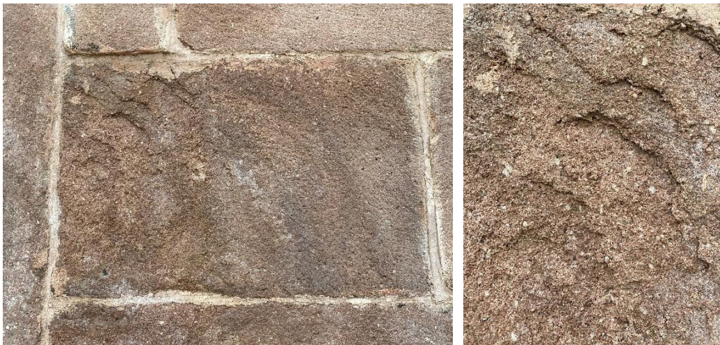
Fotoğraf 2.6. Şifâhâne Mescidinde tespit edilen levhalar halinde ayrılma (Ünal, 2023)
