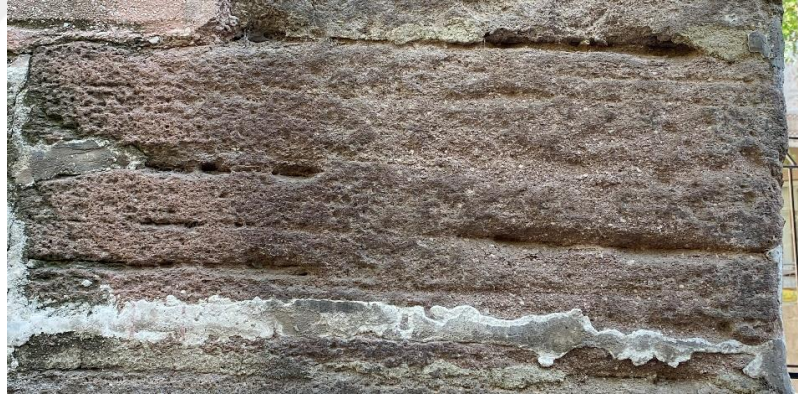
Fotoğraf 2.11. Hoca Ahmet Fakih Camisindeki taşlarda görülen diferansiyel erozyon (Ünal, 2023)
