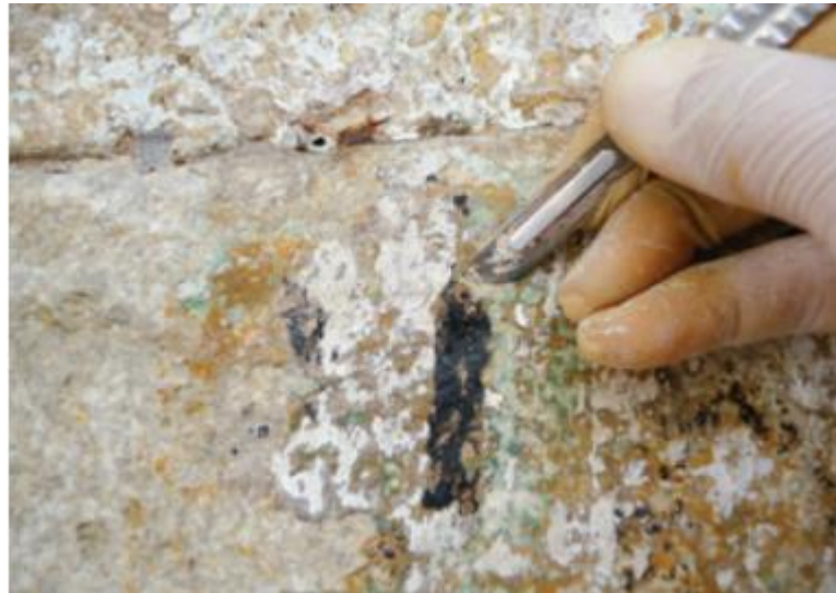
Fotoğraf 3.2. Mekanik temizleme uygulaması (Ersen, 2011)
