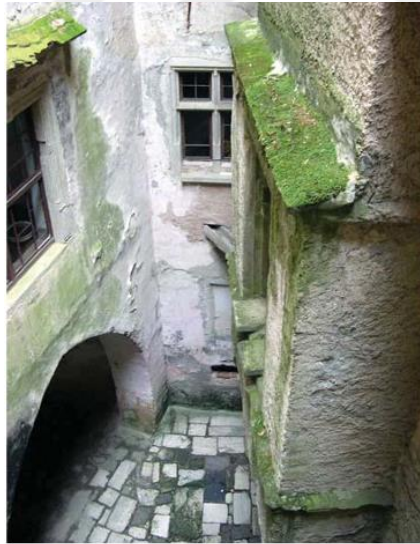
Fotoğraf 2.20. Taş duvar üzerinde gelişen yeşil algler (ICOMOS-ISCS, 2008)
