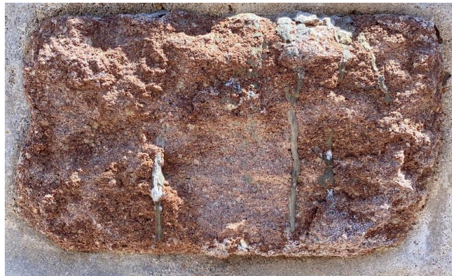
Fotoğraf 2.17. Sille Aya Eleni Kilise Müzesindeki yapı malzemesinde görülen birikme (Ünal, 2023)
