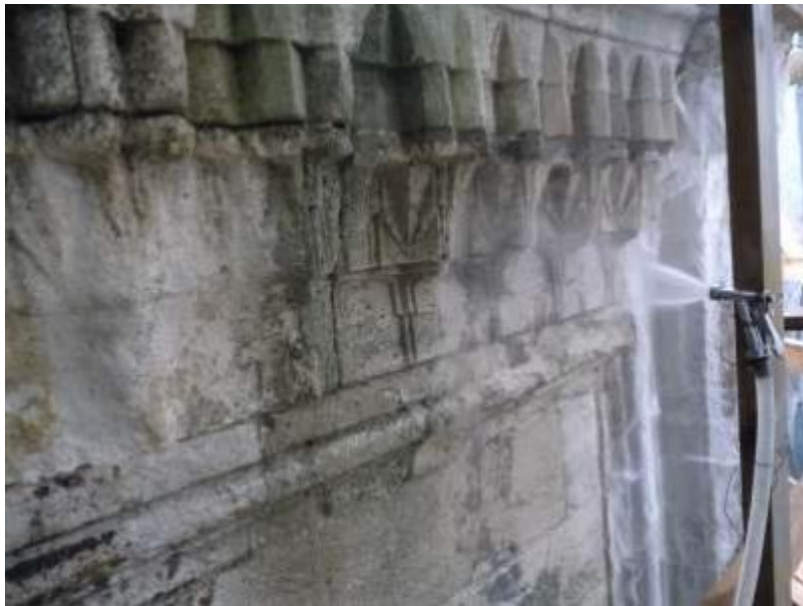
Fotoğraf 3.5. Atomize su püskürtme uygulamasıyla temizlik (MEB, 2013)
