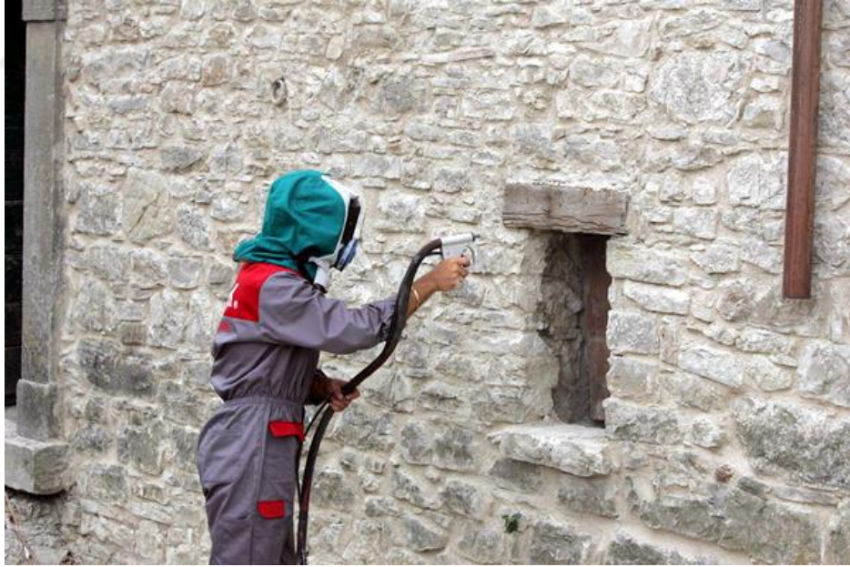
Fotoğraf 3.4. Kontrollü kumlama uygulaması (Anonim, 2019)
