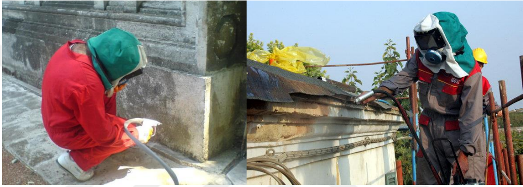
Fotoğraf 3.3. Kuru buz ile temizlik uygulaması (Ersen, 2011)
