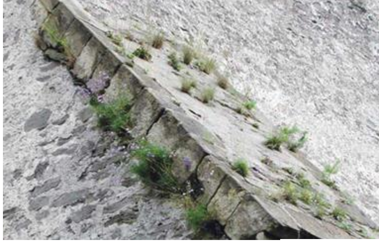
Fotoğraf 2.24. Kumtaşı duvar üzerinde büyüyen bitkiler (ICOMOS-ISCS, 2008)
