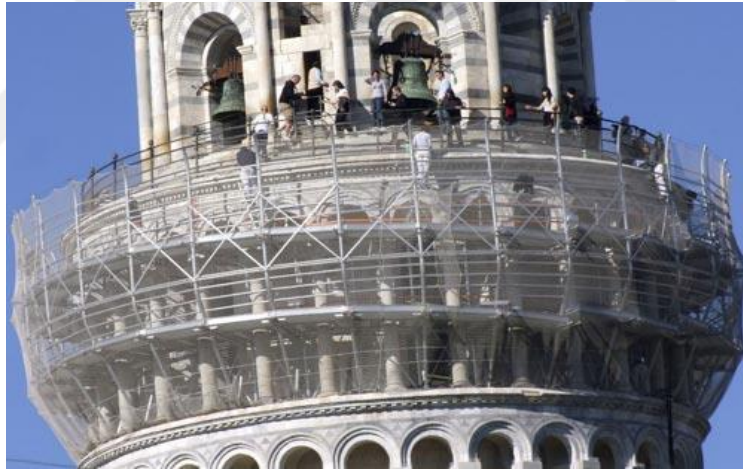
Şekil 14. Pisa Kulesi Restorasyonu
