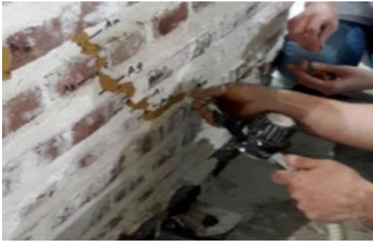
Şekil 3. Sağlamaştırmada Kimyasal Enjeksiyonu
