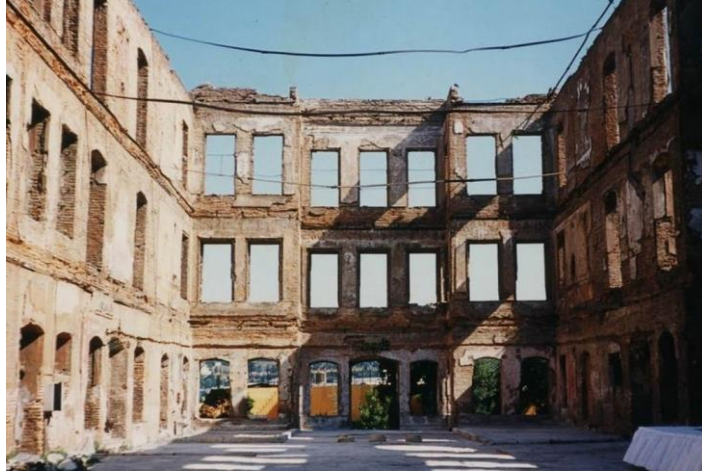
Şekil 25. Esmâ Sultan Yalısı / Restorasyon Öncesi
