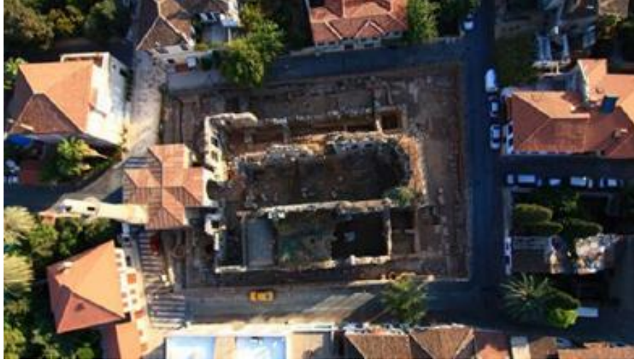
Şekil 27. Kesik Minare'nin Müdahale Öncesi Üstten Görünüşü
