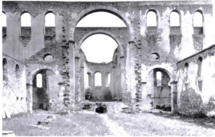
Şekil 23. Bad Hersfeld Manastırı'nın Restorasyon Öncesi Durumu
