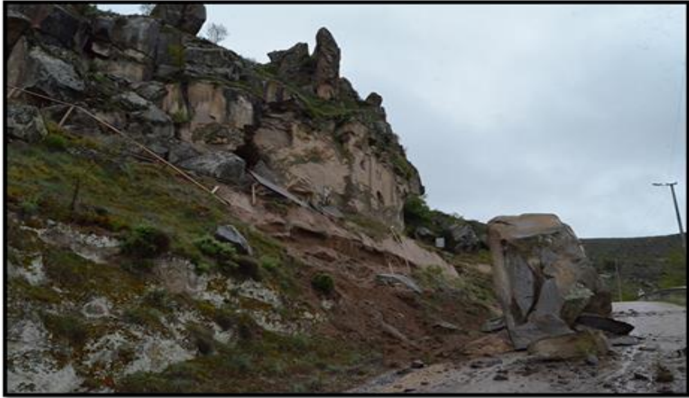
Şekil 4. 8. Belisırma Köyü Kaya Düşmesi Yaşanan Alan (URL, 11)
