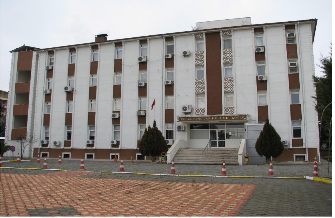
Foto3. Kovancılar( Elazığ) Hükümet Konağı Binasından bir görünüm (2019)
