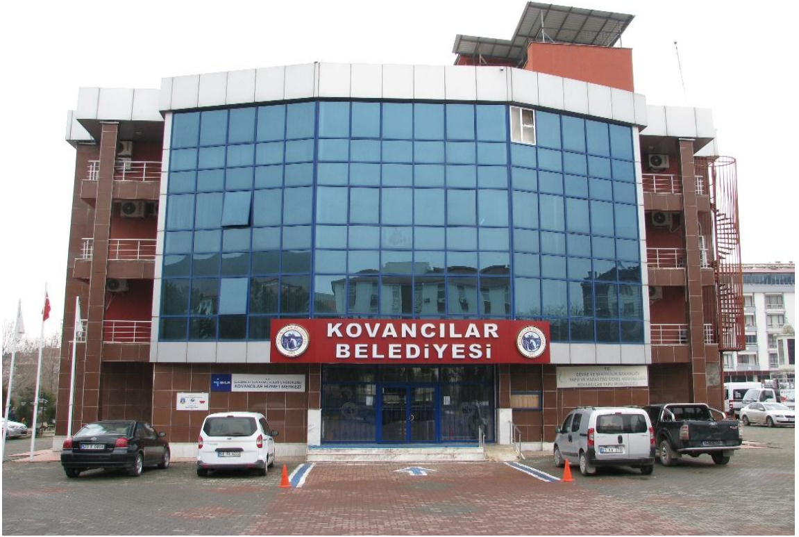
Foto2. Kovancılar( Elazığ) Belediye Binasından bir görünüm (2019)
