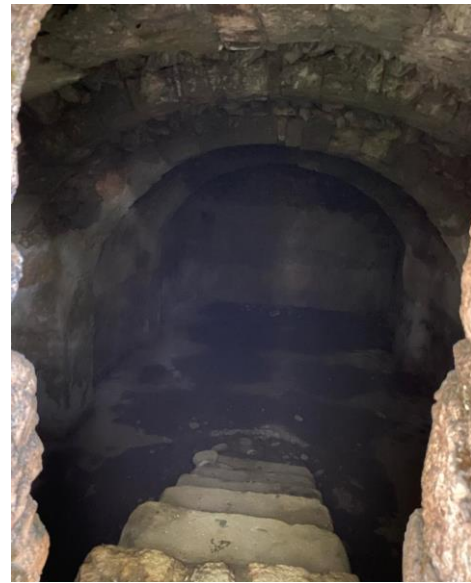
Görsel 3.57 Sarnıca İnilen Merdiven ve Kemerli Çatısı
