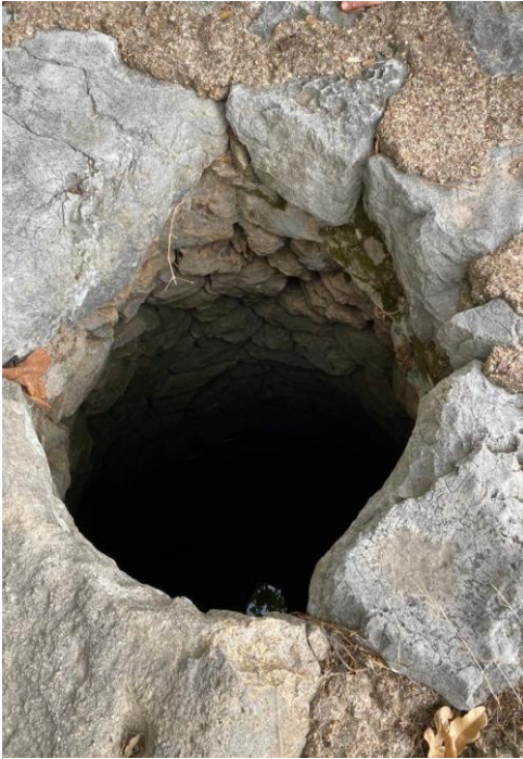
Görsel 3.51 Ağız Kısmı Dar Altı Geniş Sarnıç Kuyusu
