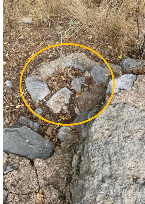
Görsel 3.52 Sadece Yük Hayvanı Olan Eşek ve Atları Sulamak İçin Kullanılan Beton Hatıl
