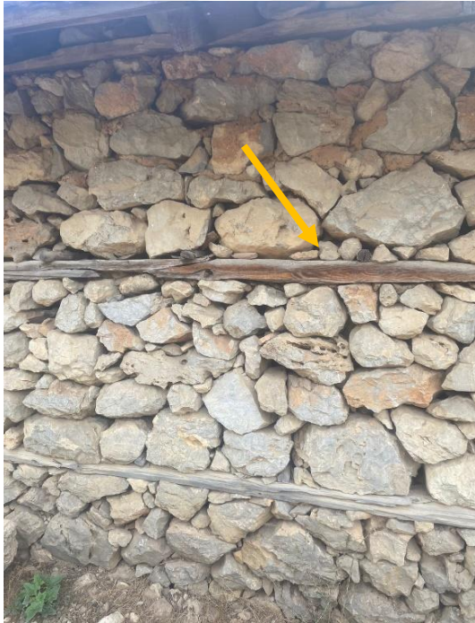
Görsel 3.21 Taş Duvara Uygulanan Çerçeve Yöntemi
