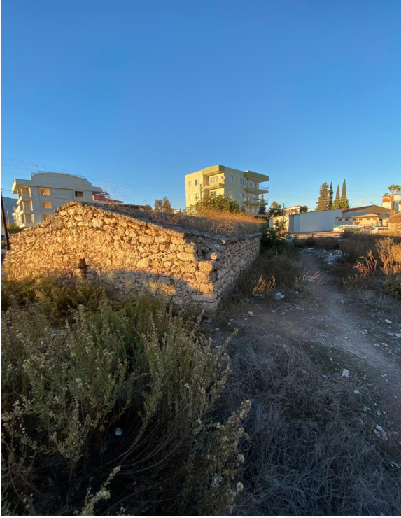
Görsel 3. 62 Döşemealtı İlçesi Yeniköy Mahallesinde Şehir Merkezi İçerisinde Kalmış Dolma Sarnıç ve Dolma Sarnıcın Çatısına Kaplarla Su Çekmek İçin Yapılan Kuyu
