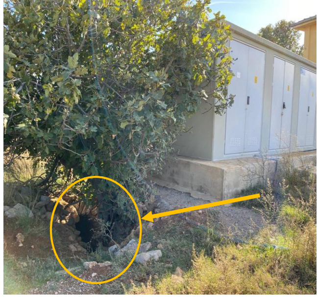
Görsel 3.55 Elektrik Trafoları Arasında Kayıp Olmuş Sarnıç Girişi
