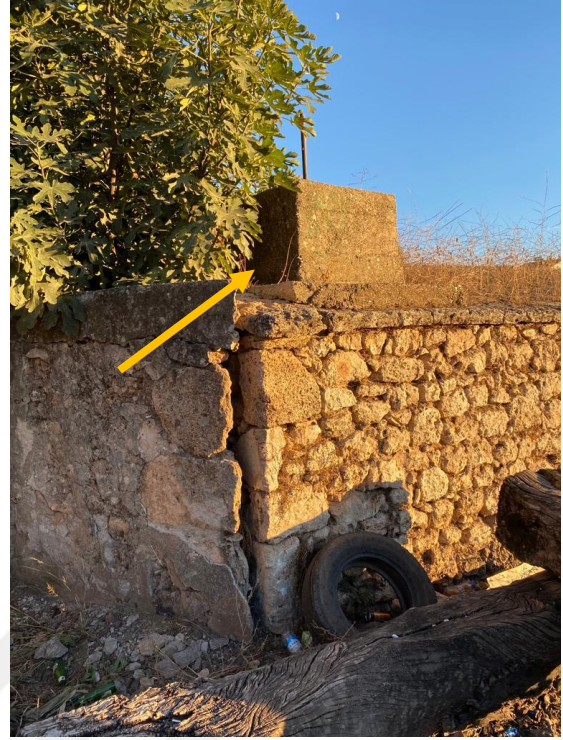
Görsel 3. 62 Döşemealtı İlçesi Yeniköy Mahallesinde Şehir Merkezi İçerisinde Kalmış Dolma Sarnıç ve Dolma Sarnıcın Çatısına Kaplarla Su Çekmek İçin Yapılan Kuyu
