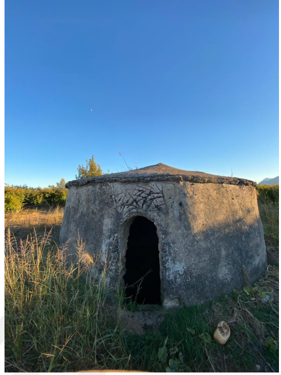
Görsel 3.59 Döşemealtı İlçesi Çıglık Mahallesiinde Yer Alan Koni Çatılı Dolma Sarnıç
