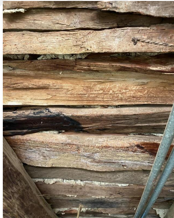
Görsel 3.22 Taban Yapımı İçin Döşenen Pardı
