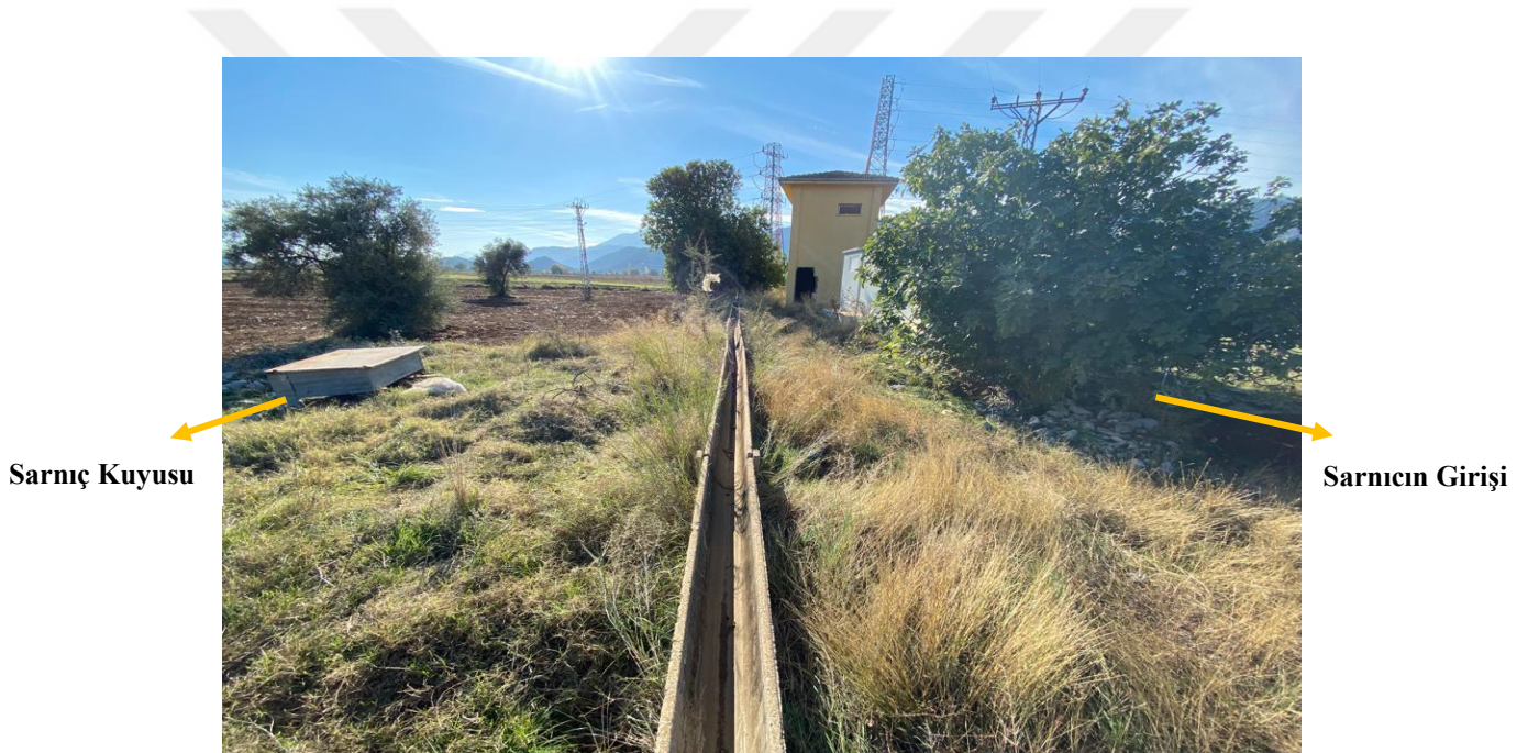
Görsel 3.53 Döşemeağızı Bölgesinde Bulunan Merdivenli Kuyulu Sarnıç
