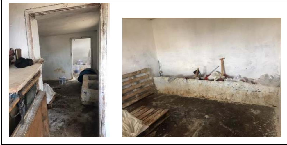
Şekil 4.13. Örnek Ev Bodrum Kat İçerisinden Çekilmiş Görsel
