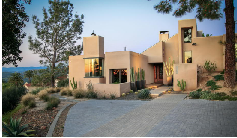
Şekil 2.28. Modern mimari ile yapılmış kerpiç yapısı/San Diego-ABD (Web 29)
