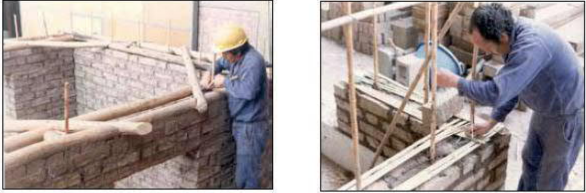
Şekil 2.38. Kerpiç duvar imalatı, (Minke, 2006)
