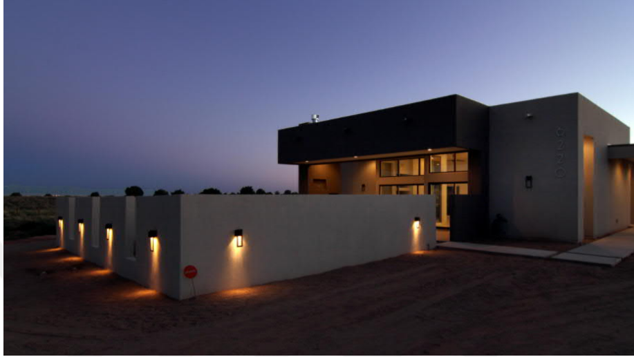
Şekil 2.39. Modern kerpiç yapı/Albuquerque (Web 34)
