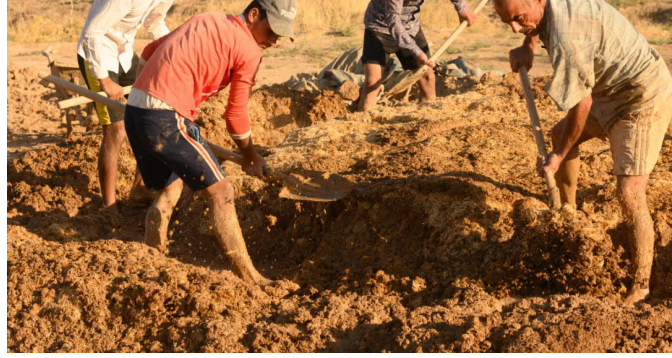
Şekil 2.36. Kerpiç harcının üretimi öncesi yoğrulması, (Web 33, 2020)
