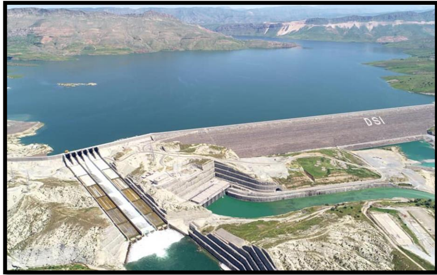
Şekil 2.5 İlus barajı ve hes yapıları ( https://www.ekogundem.com.tr 2021)
