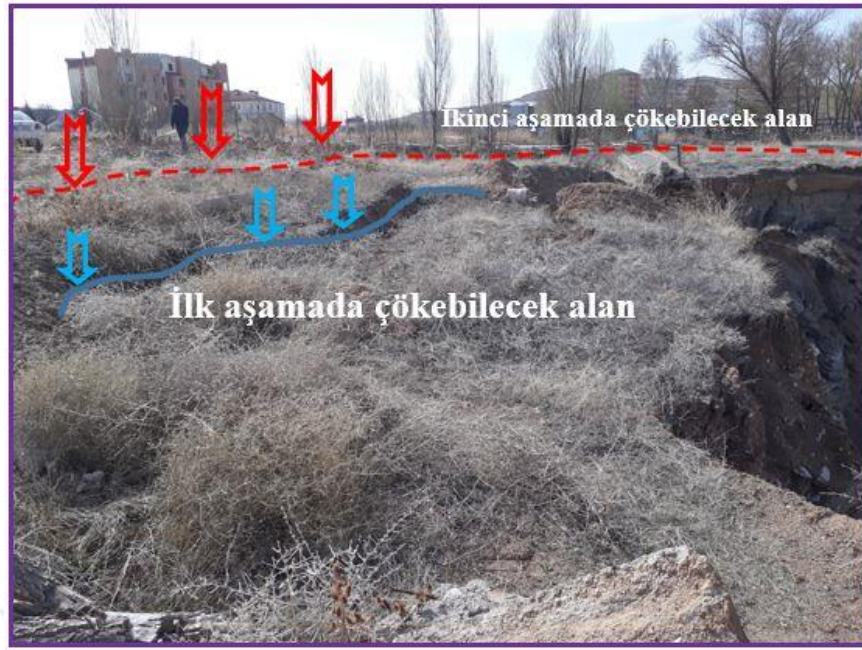
Şekil 3.12: Çöküntü çevresindeki geniş çaplı yarık ve çatlaklar.
