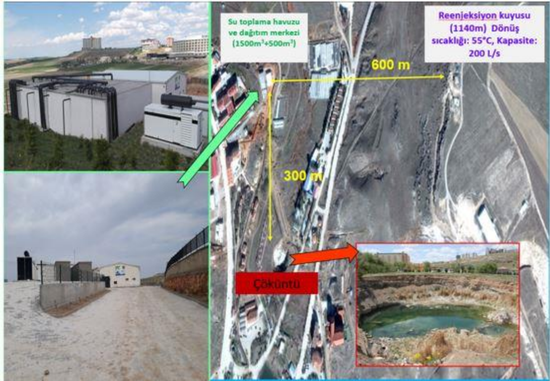
Şekil 4.1: KJA'da iyileştirme çalışmaları.
