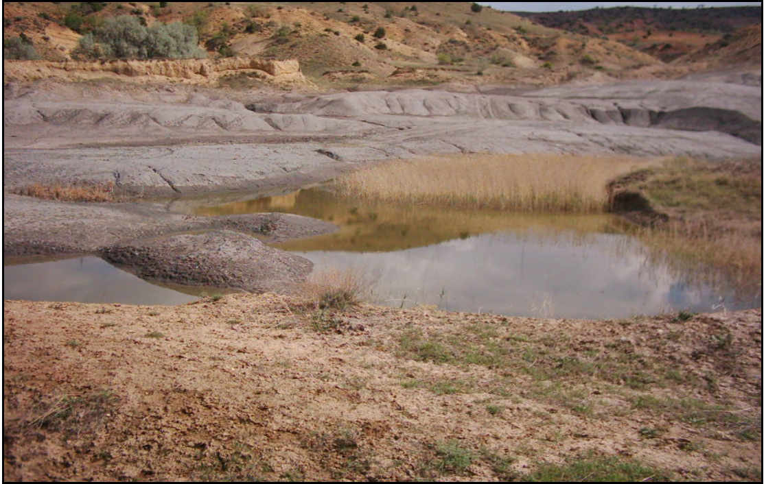
Resim 2.2. Yapılması planlanan düzenli depolama sahasının yeri
