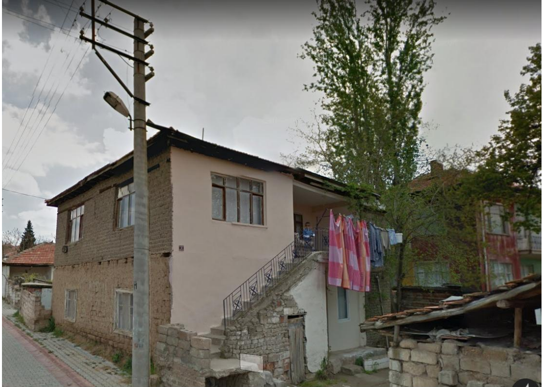
Foto 28. Kırıkkale Şehri'nde Bulunan Geleneksel Kerpiç Mesken
