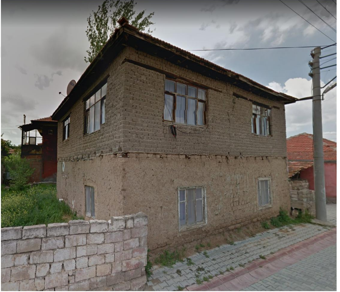
Foto 29. Kırıkkale Şehri’nde Bulunan Geleneksel Kerpiç Mesken
