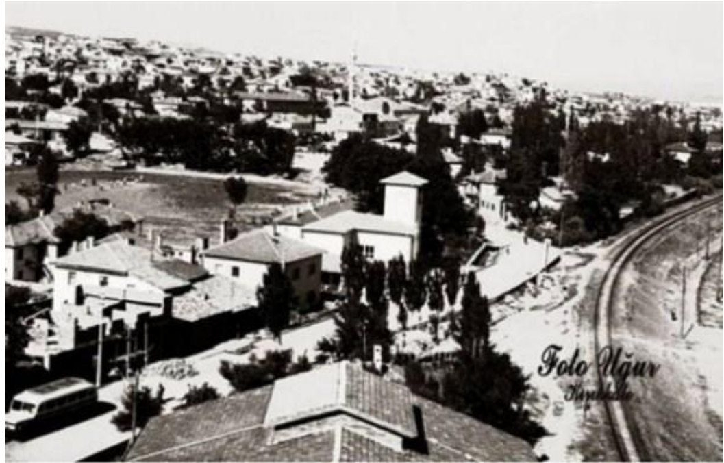
Foto 6. Kırıkkale Şehri'ndeki Tren İstasyonu ve Demiryolu
