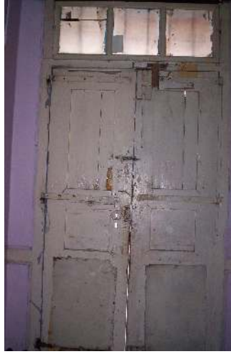
Resim 3.98 Giriş Kapısı Taşlıktan görünüm
