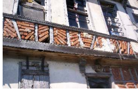
Resim 3.101 Tuğla Örgü Detayı
