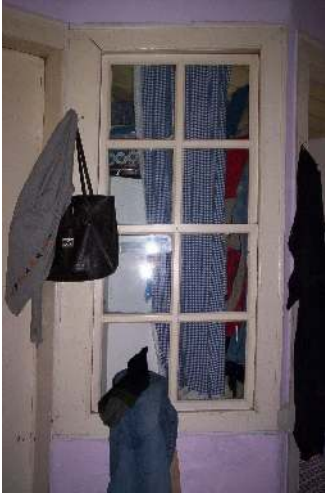
Resim 3.97 Mutfak Penceresi Taşlıktan Görünüm
