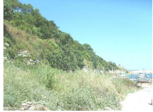
Resim 3.3 Güney Cephesi Surları
