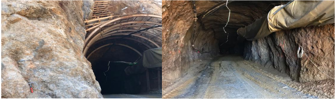
Şekil 12. Cevherleşme sahasındaki galeriden görünüm
