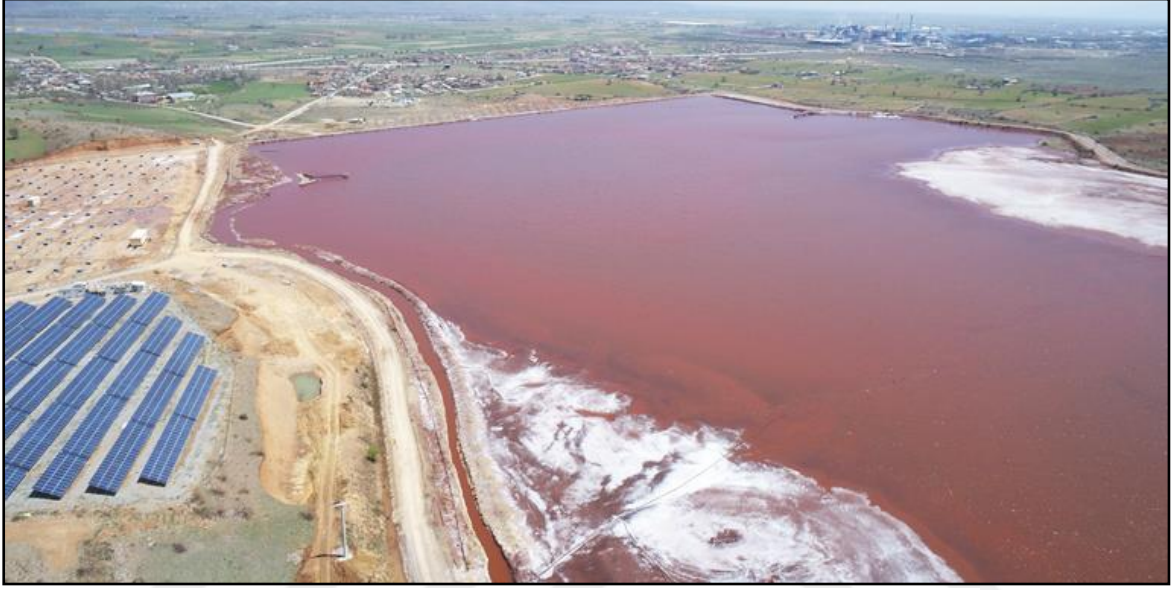
Şekil 2.2 Eti Alüminyum A.Ş. Seydişehir İşletmesi kırmızı çamur atık barajı
