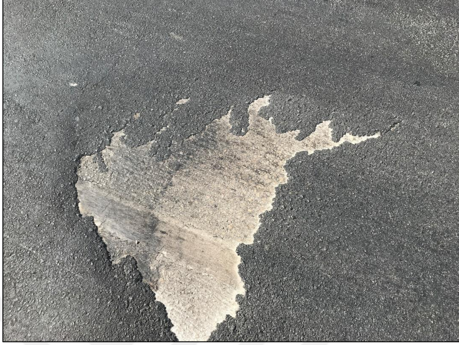
Şekil 1.3. Soyulma ve Sökülme Problemi
