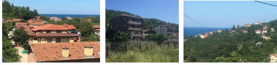
Şekil 4.4. Gemiciler Köyü yüksek katlı yapı örneği
