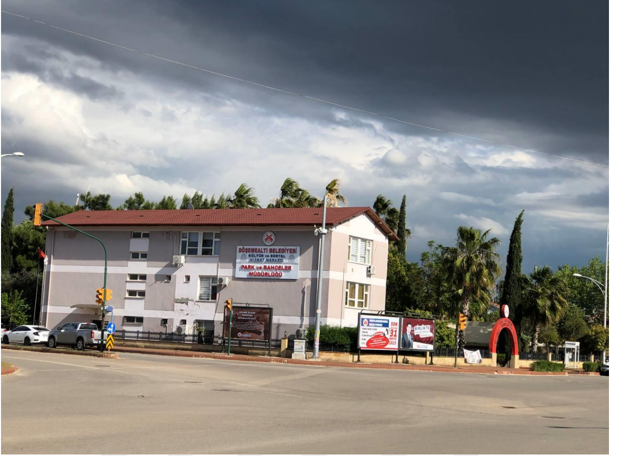
Döşemealtı Belediyesi Kültür ve Sosyal Hizmet Merkezi (Yeşilbayır Mahallesi)
