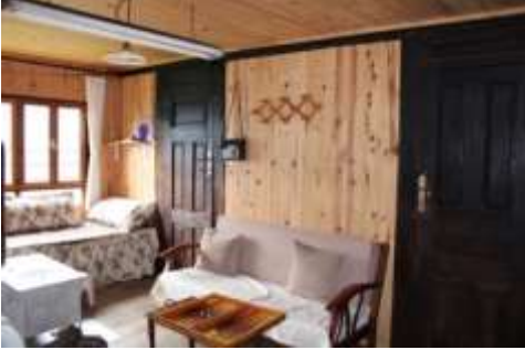
Malzemesi değiştirilmiş duvarda özgün kapı
