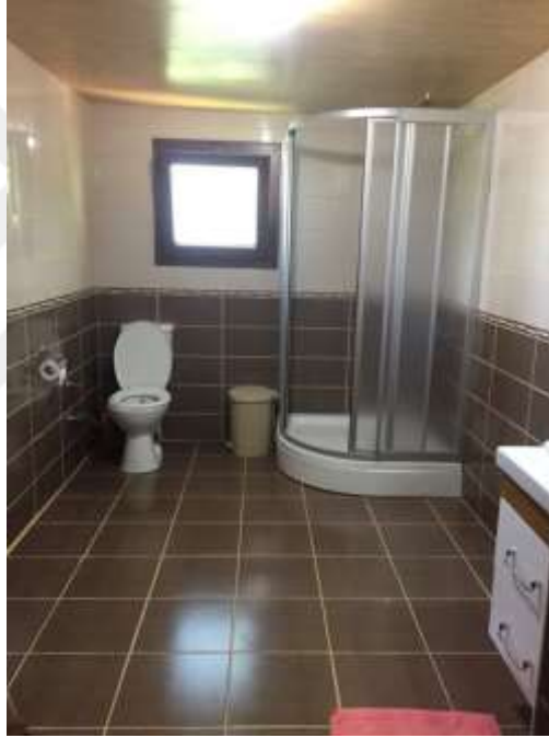
Şekil 87. Ambar mekânın banyo/tuvalete dönüştürülmesi (K9 konutu)
