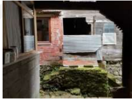
Güney cephesi girişi
