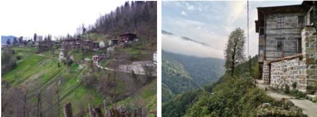
Şekil 4. Çamlıhemşin kırsal konutlarının yerleşimi
