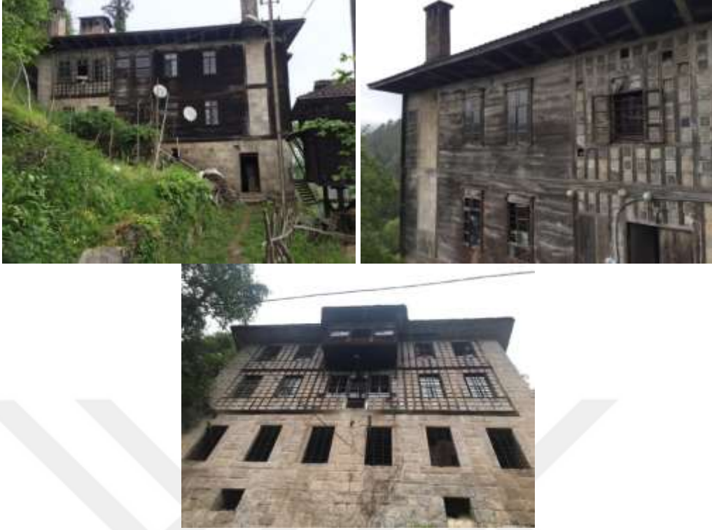
Şekil 8. Göz dolma sistem (Zorlu fotoğraf arşivi, 2005)
