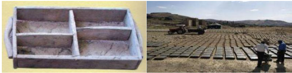
Şekil 2.2 Dört Gözlü Ahşap Kerpiç Kalıbı (solda) ve Kalıptan Çıkarılan Kerpicingin Güneşte Kurutulması (sağda) (Gündoğdu, 2019)
