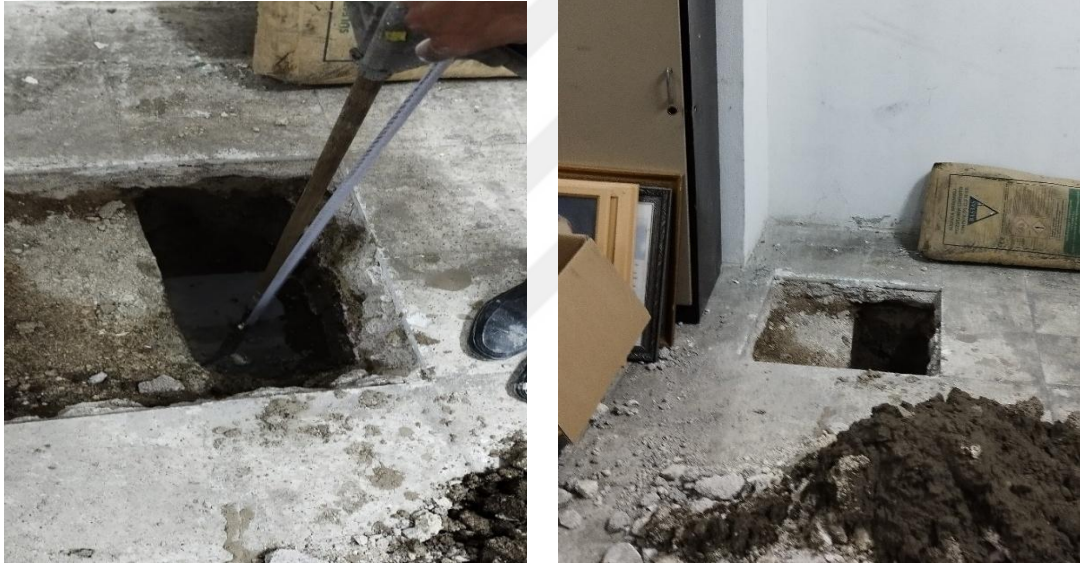
Şekil 4.9. Temel Çukuru Kazılması ve Ölçümü
