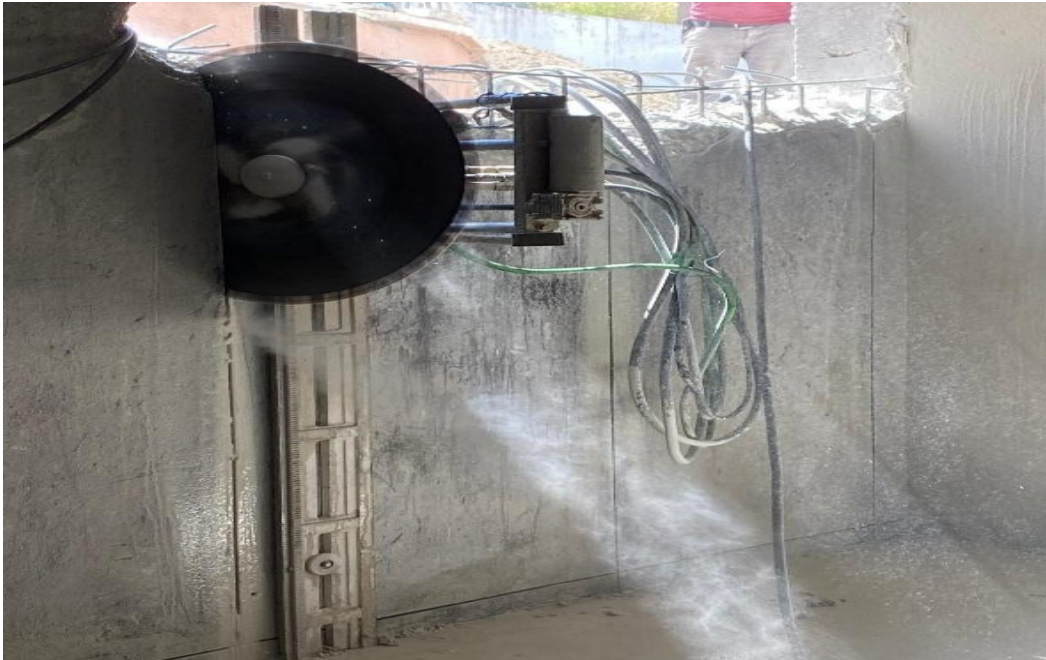
Şekil 4.98. Hidrolik makinelerle bodrum perdesi kesilmesi
