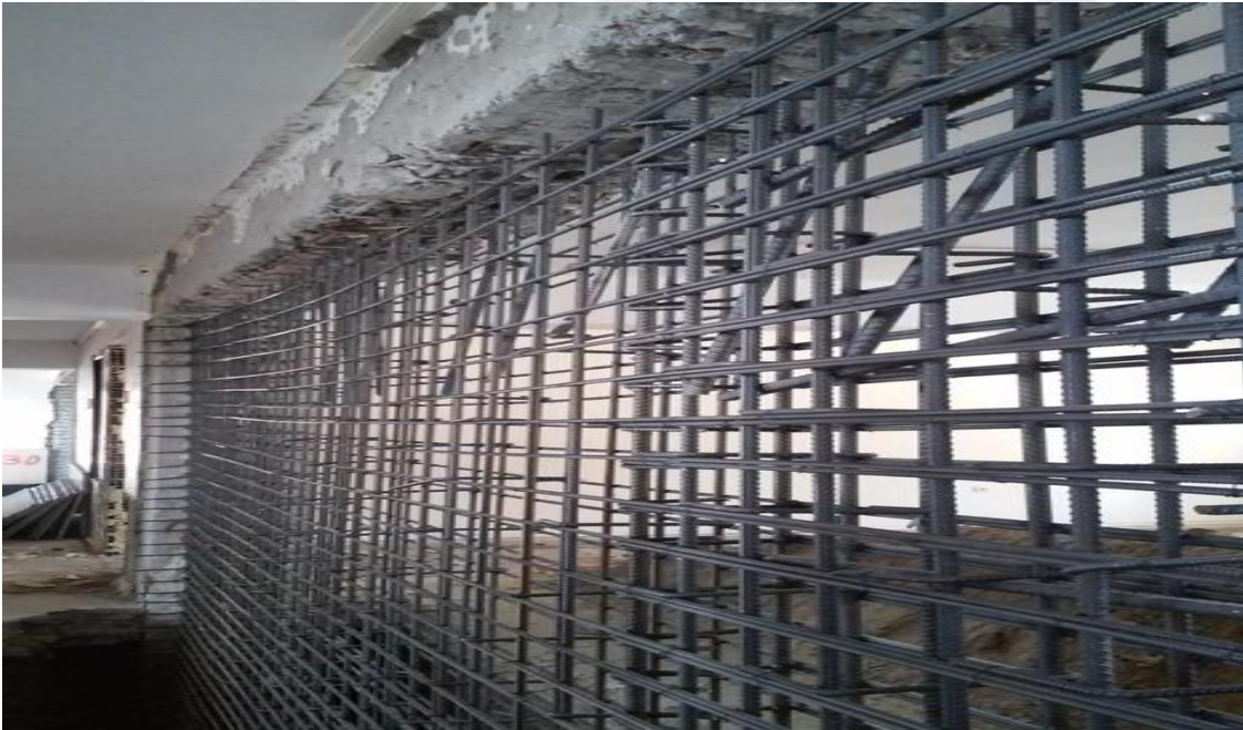
Şekil 4.96. Betonarme perde eklenmesine örnek
