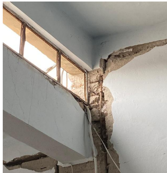
Şekil 4.84. Güçlendirme yapılmamış kısa kolon
