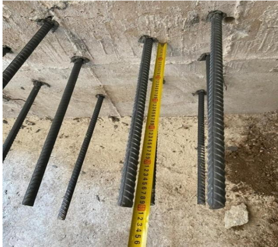
Şekil 4.107. Ankraj uzunluklarının projeye uygunluğunun ölçülmesi
