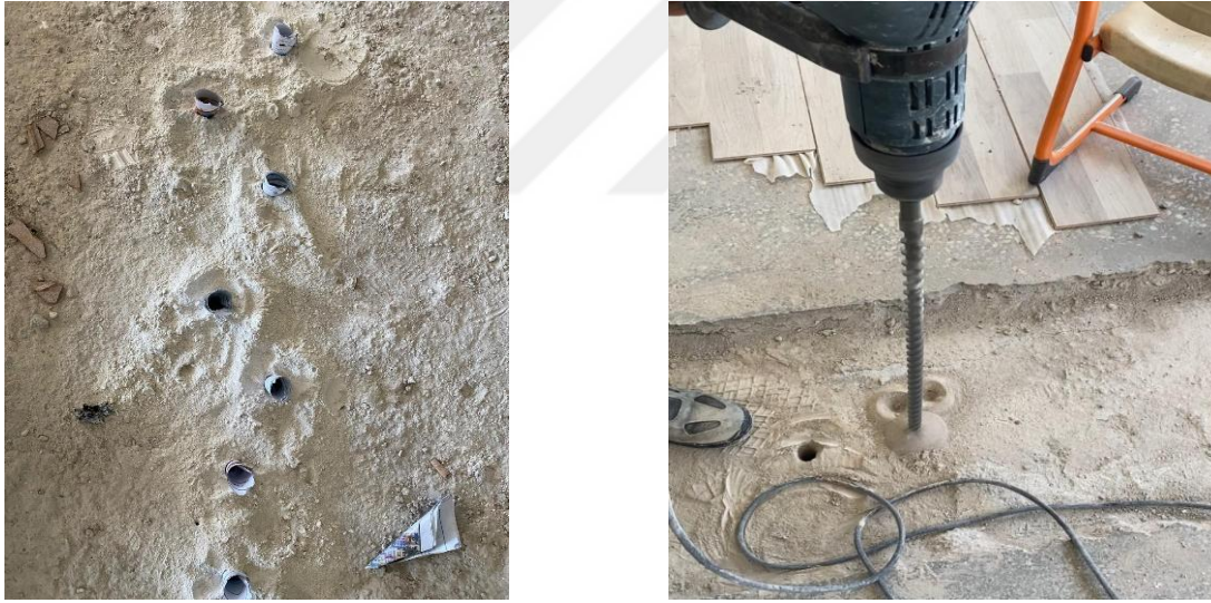
Şekil 4.104. Ankraj deliğinin açılması
