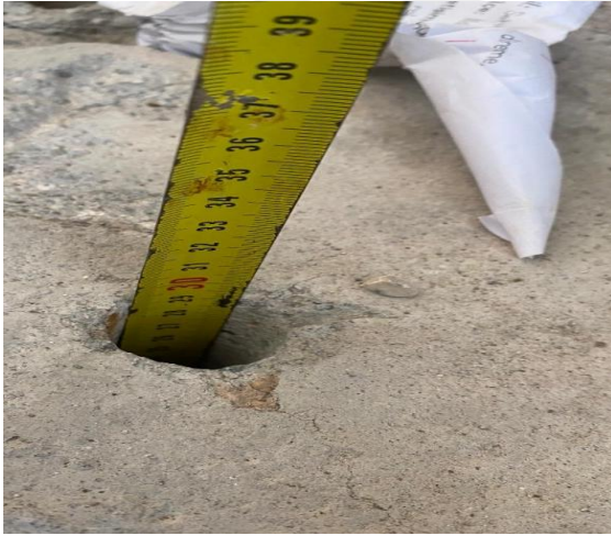
Şekil 4.106. Ankraj delikleri uzunluğunun projeye uygunluğunun ölçülmesi
