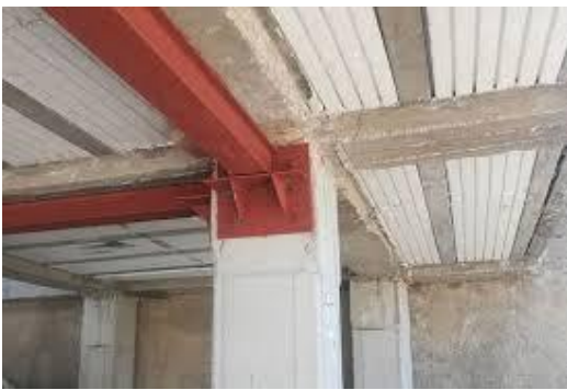
Şekil 4.88. Kirişlerde çelik levhalarla sargı yapılması
