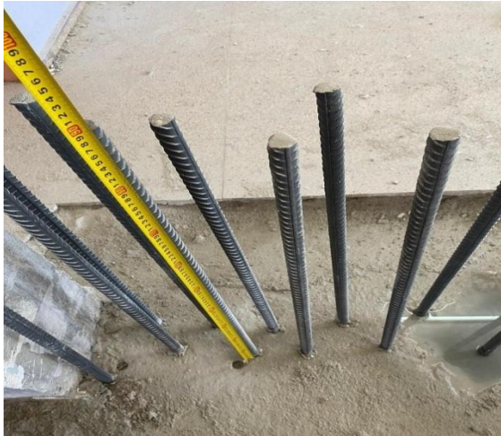
Şekil 4.107. Ankraj uzunluklarının projeye uygunluğunun ölçülmesi
