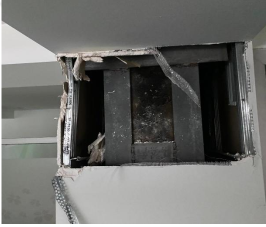
Şekil 4.83. Çelikle güçlendirilmiş kısa kolon
