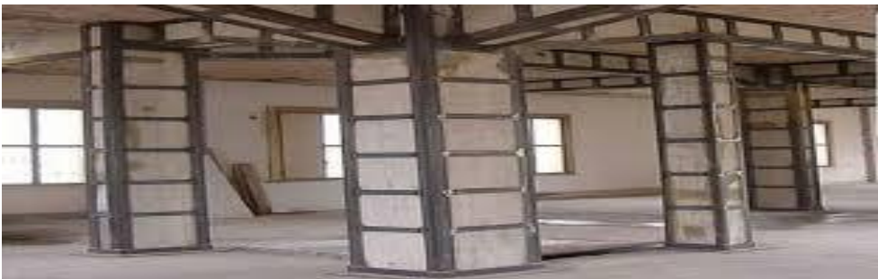
Şekil 4.82. Çelikle güçlendirilmiş kolon (www.carbonier.com)
