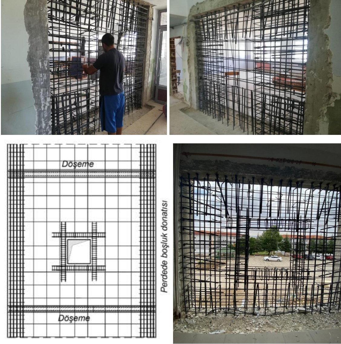
Şekil 4.114. Birinci okul Gp2 perdesi demir donatı yerleştirilmesi
