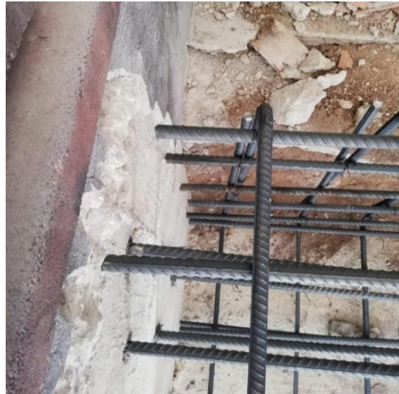
Şekil 4.100. İkinci okula temel yapısı eklenmesi
