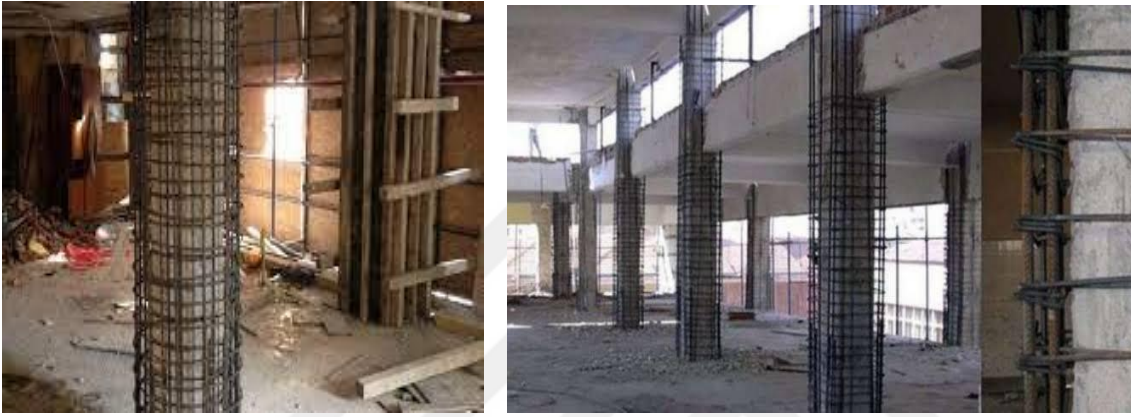
Şekil 4.81. Kolonun mantolama ile güçlendirilmesine uygulama örnekleri
