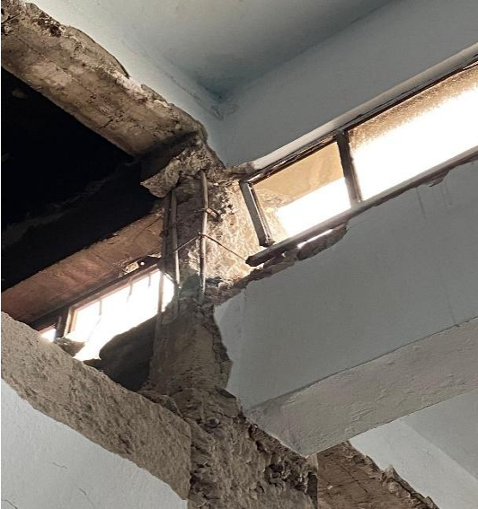
Şekil 4.84. Güçlendirme yapılmamış kısa kolon
