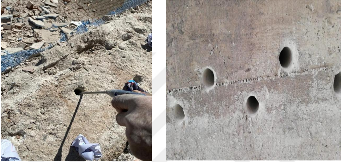
Şekil 4.108. Ankraj delikleri temizlenirken ve temizlenmiş hali
