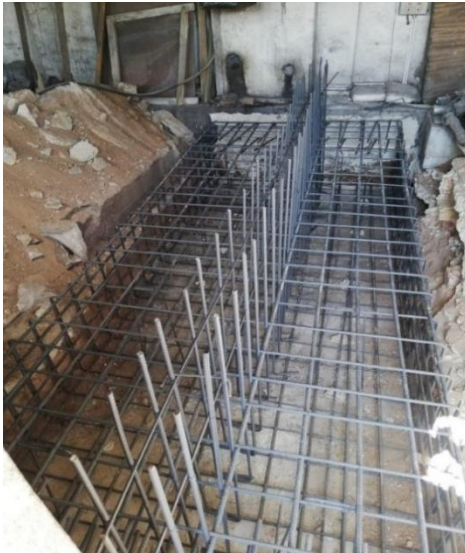
Şekil 4.100. İkinci okula temel yapısı eklenmesi
