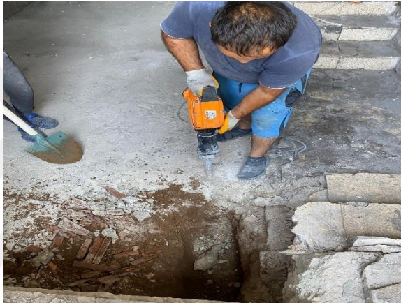
Şekil 4.99. Temel kazısı yapılması
