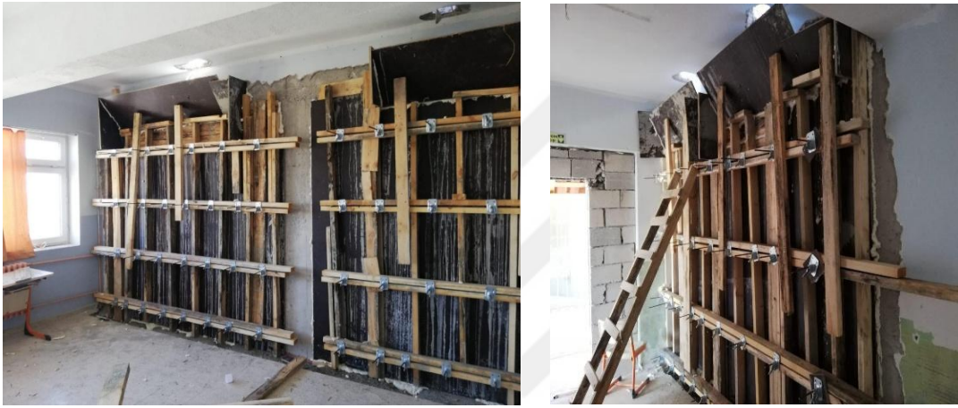
Şekil 4.115. Perde kalıplarının yapılması
