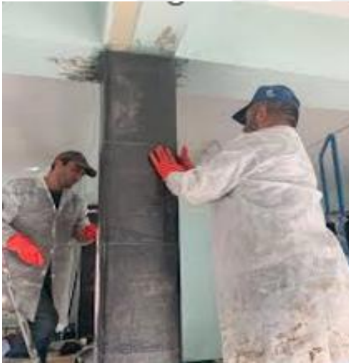
Şekil 4.85. Kolonların FRP ile sarılması ve kesiti (Atay,2010)
