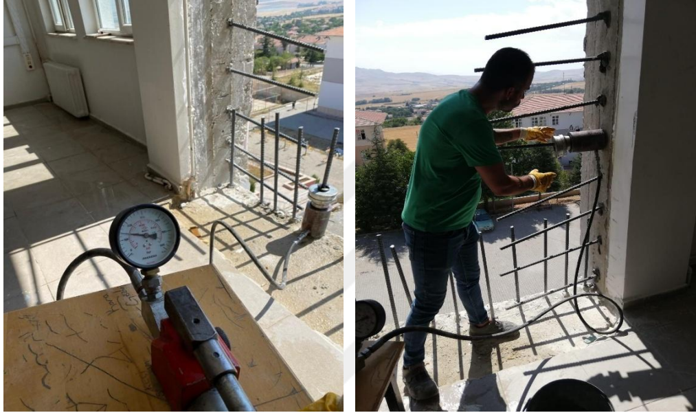
Şekil 4.111. Ankraj çekme deneyleri yapılması
