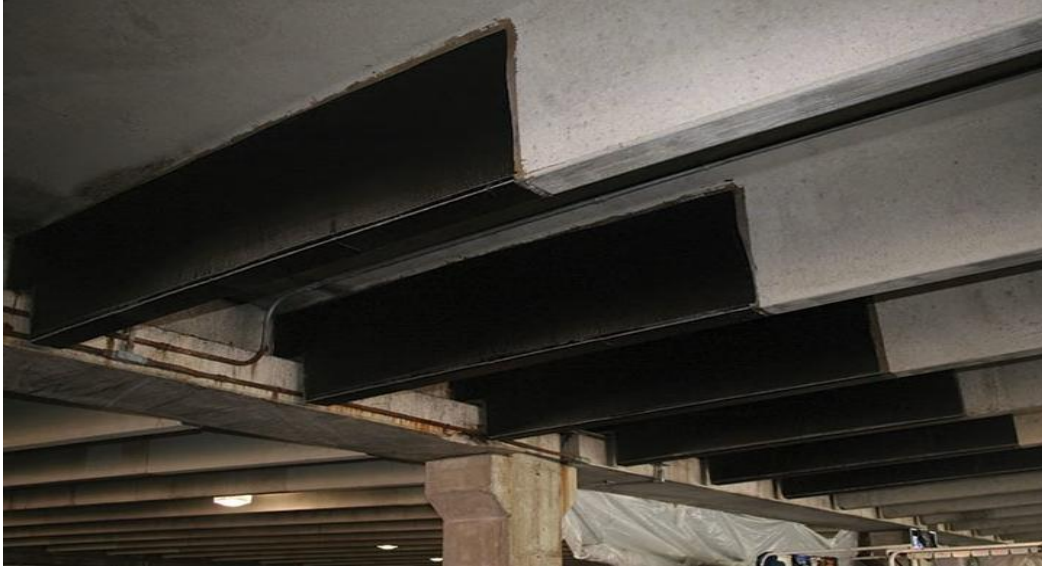
Şekil 4.87. Kirişlerde CFRP uygulaması
