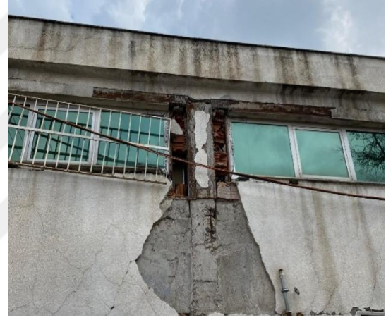
Şekil 4.83. Çelikle güçlendirilmiş kısa kolon
