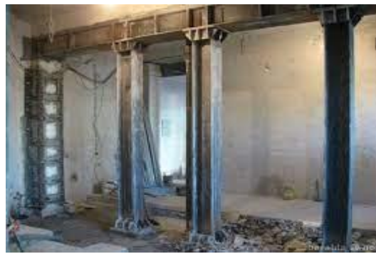
Şekil 4.88. Kirişlerde çelik levhalarla sargı yapılması
