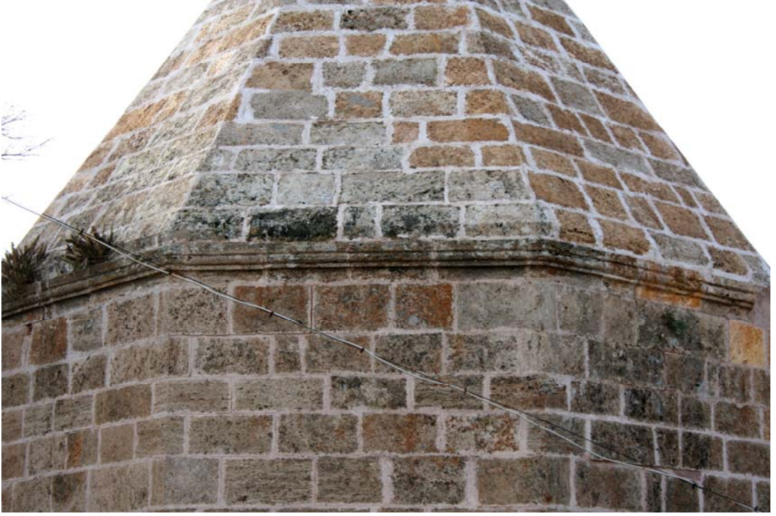
Fotoğraf-73: Kalender Baba Türbesi, kubbe ve külâh arasındaki silmeler.
