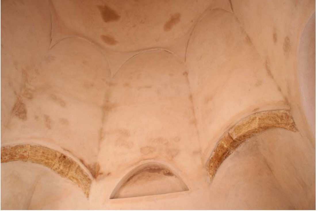
Fotoğraf-78: Kalender Baba Türbesi, batı cephedeki tromplar ve kaskanak.
