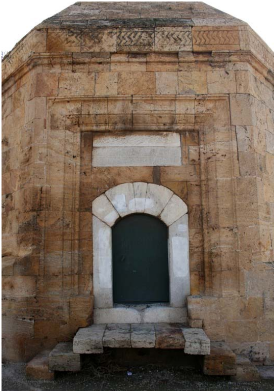
Fotoğraf-52: Fatma Hatun Türbesi kuzey cephe.
