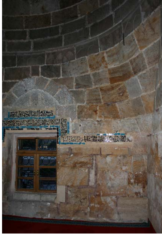
Fotoğraf-39: Caca Bey Türbesi ziyaretgâh bölümü, iç mekân kubbe geçişleri.
