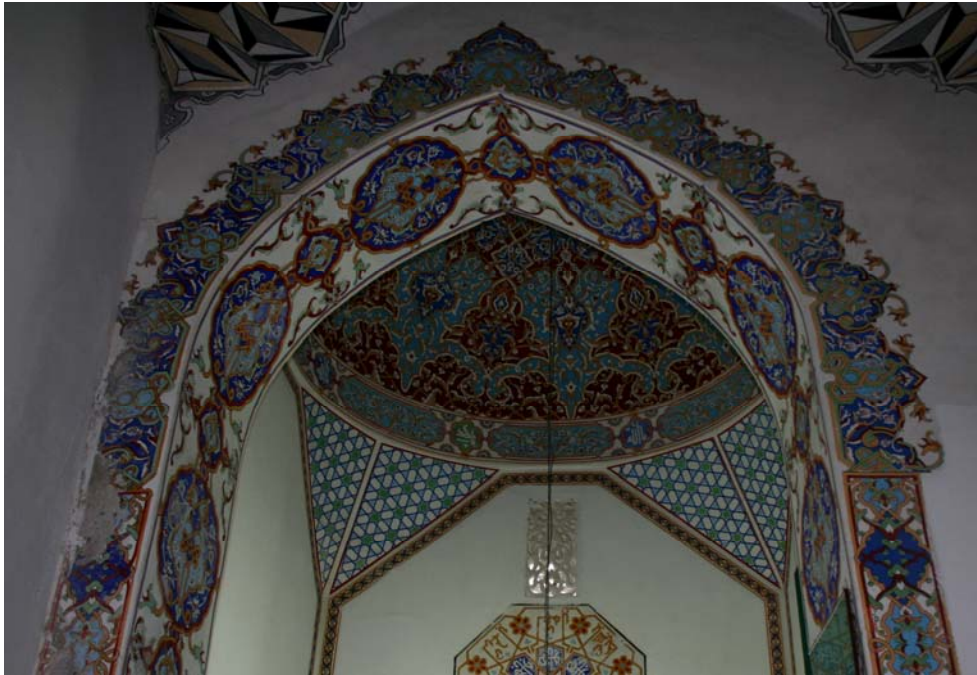
Fotoğraf-66: Ahi Evren Türbesi, örtü geçiş elemanları.
