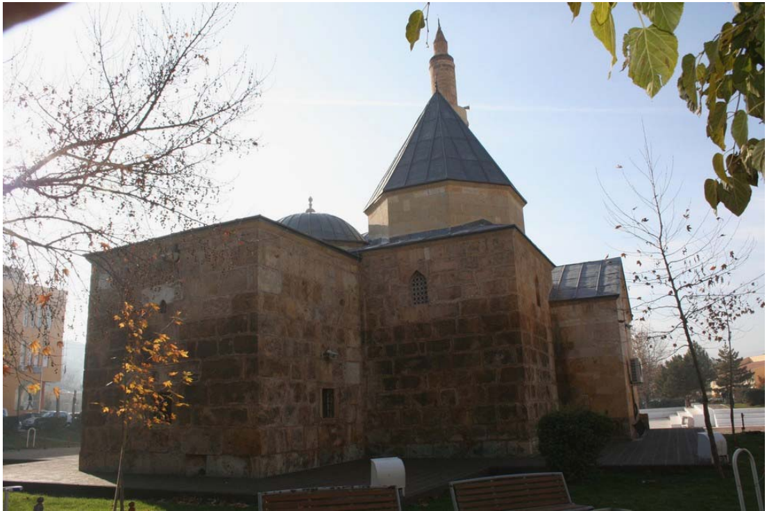
Fotoğraf-58: Ahi Evren Zaviyesi kuzeydoğu cephe.
