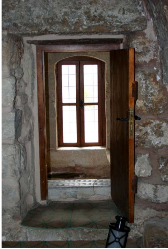
Fotoğraf-99: Âşık Paşa Türbesi, esas türbe mekânı ve koridorun kuzey cephesindeki pencerenin görünüşü.
