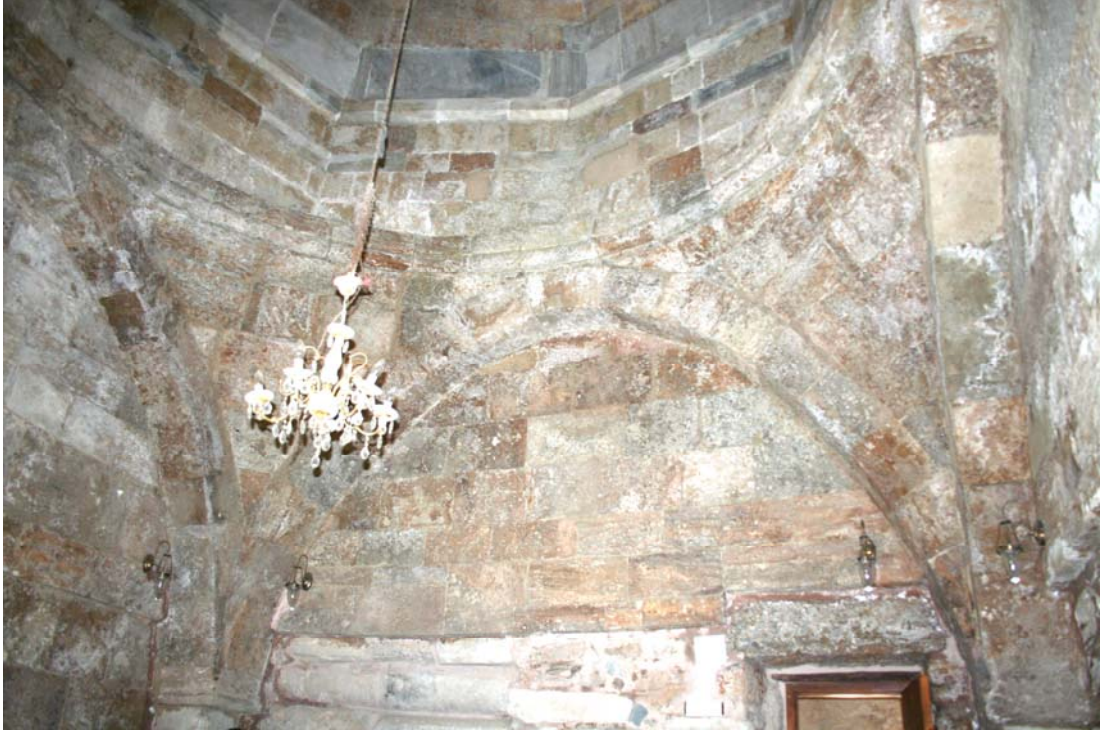
Fotoğraf-107: Âşık Paşa Türbesi, kubbe geçiş elemanları, kuzey cephe.
