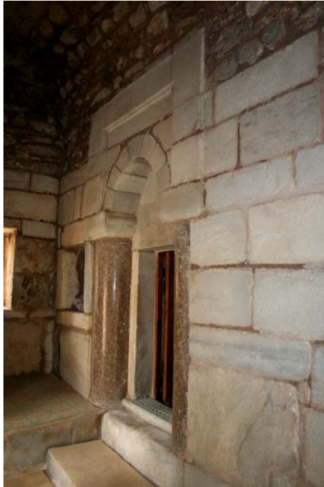
Fotoğraf-100: Âşık Paşa Türbesi, esas türbe mekânına giriş kapısı.
