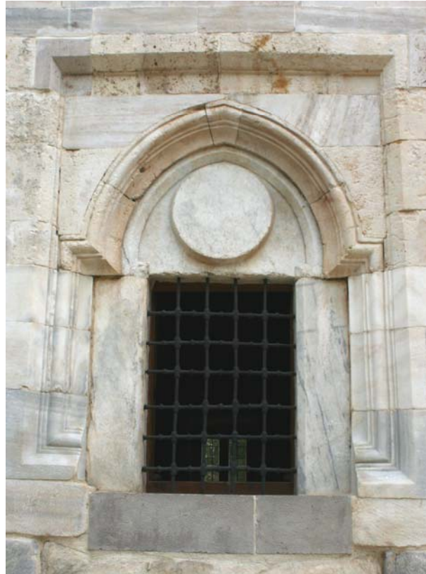
Fotoğraf-92: Âşık Paşa Türbesi, batı cephedeki pencere.
