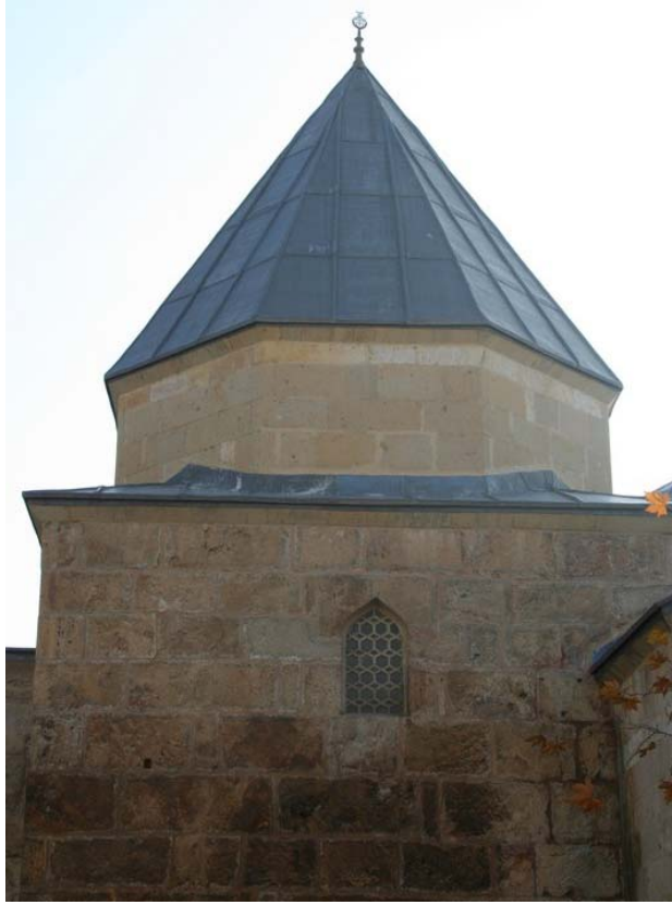
Fotoğraf-59: Ahi Evren Türbesi, kaskanak ve kûlah, kuzey cephe.
