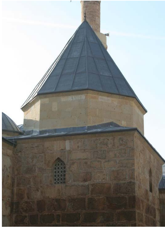
Fotoğraf-60: Ahi Evren Türbesi, kaskanak ve kûlah, doğu cephe.
