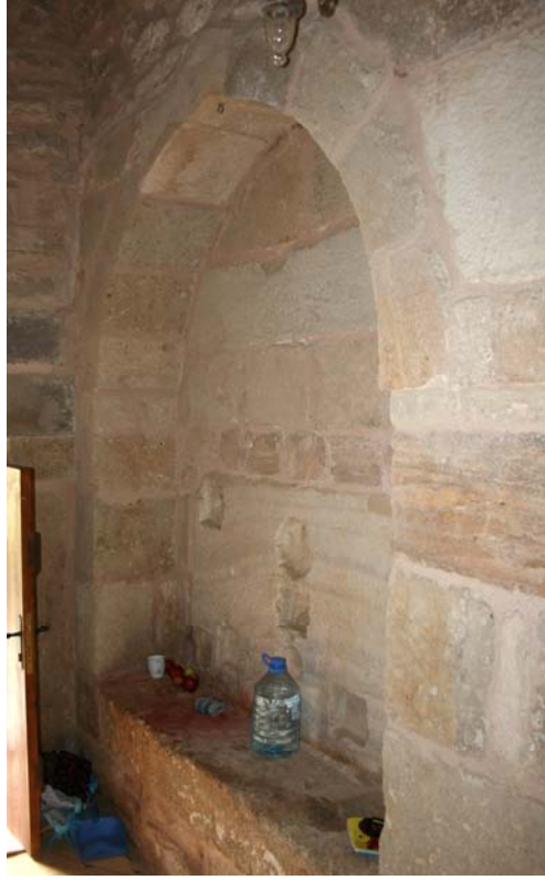
Fotoğraf-97: Âşık Paşa Türbesi, koridorun kuzey cephesindeki niş.
