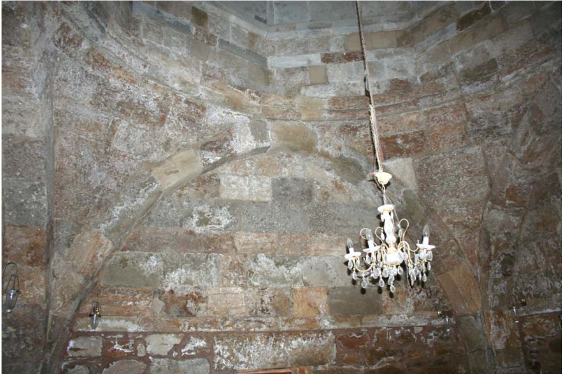
Fotoğraf-108: Âşık Paşa Türbesi, kubbe geçiş elemanları, güney cephe.
