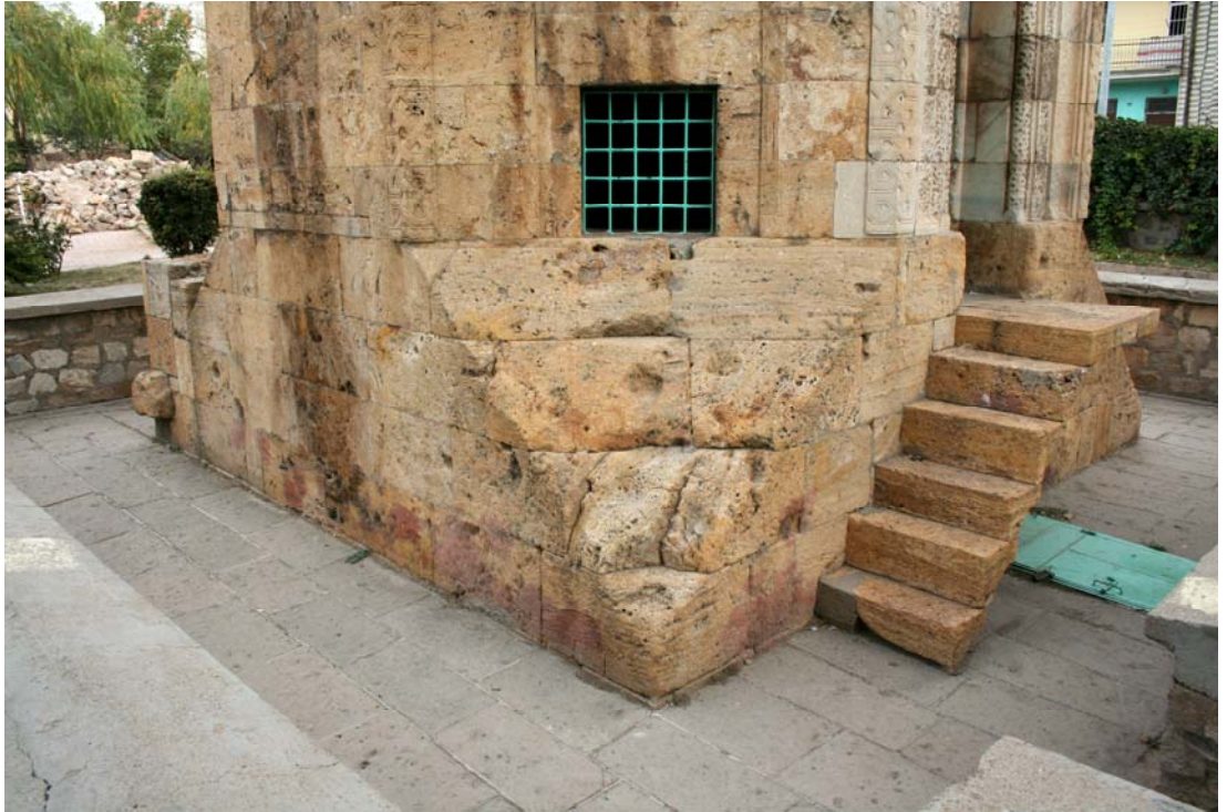
Fotoğraf-18: Melik Gazi Türbesi, güneybatı cephe.
