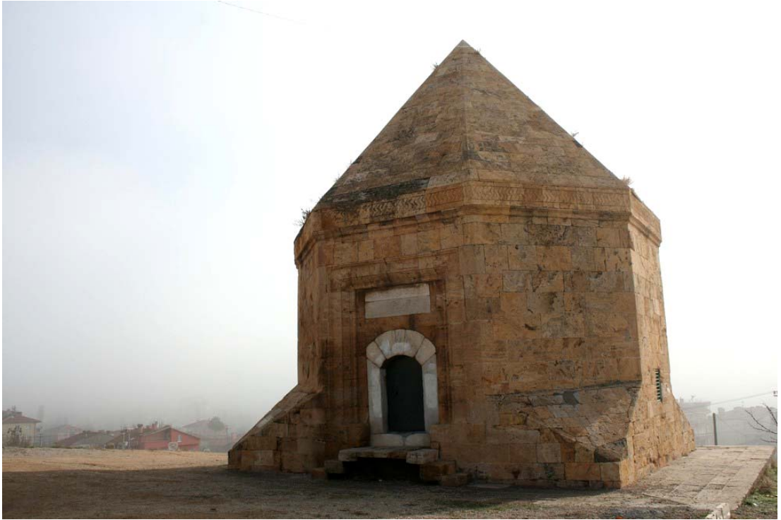
Fotoğraf-46: Fatma Hatun Türbesi kuzey cephe.
