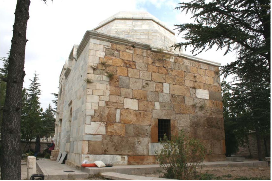
Fotoğraf-89: Âşık Paşa Türbesi, güney cephe.
