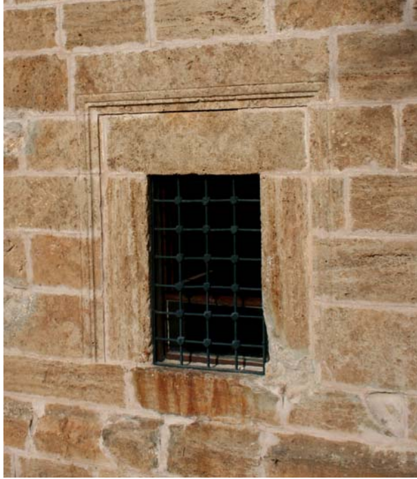
Fotoğraf-75: Kalender Baba Türbesi, güney cephedeki pencere.
