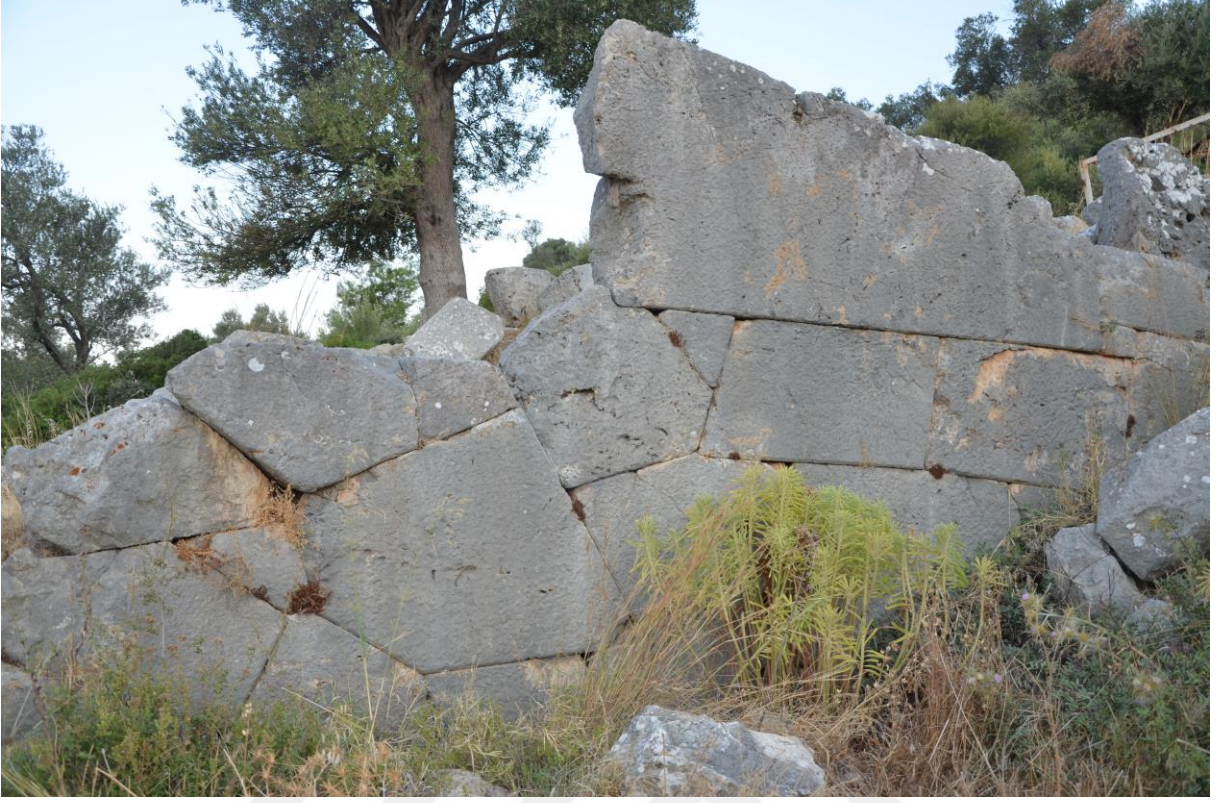
a- Lykia Yapısı, Doğu Dış, Polygonal
