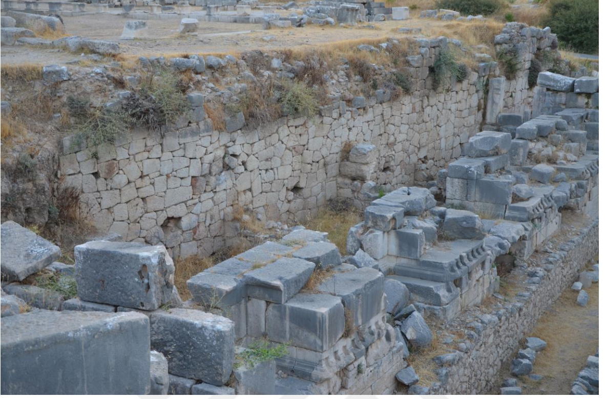
a- Tiyatro Agora Arasındaki İsitnat Duvarı
