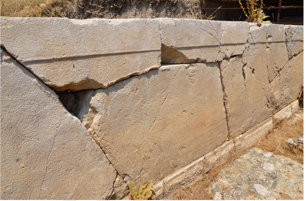
a- Güneydoğu Sektör, Doğu Duvar
