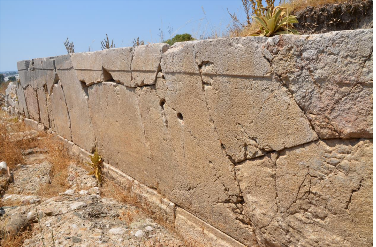
b- Güneydoğu Sektör, Doğu Duvar
