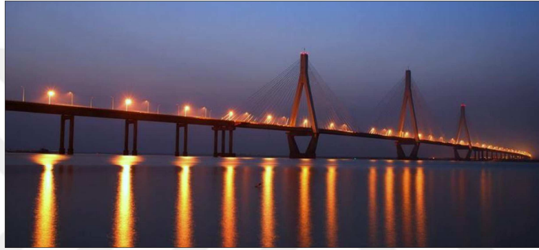
Şekil 2.13. The Dongting Lake Köprüsü, Çin [31].
