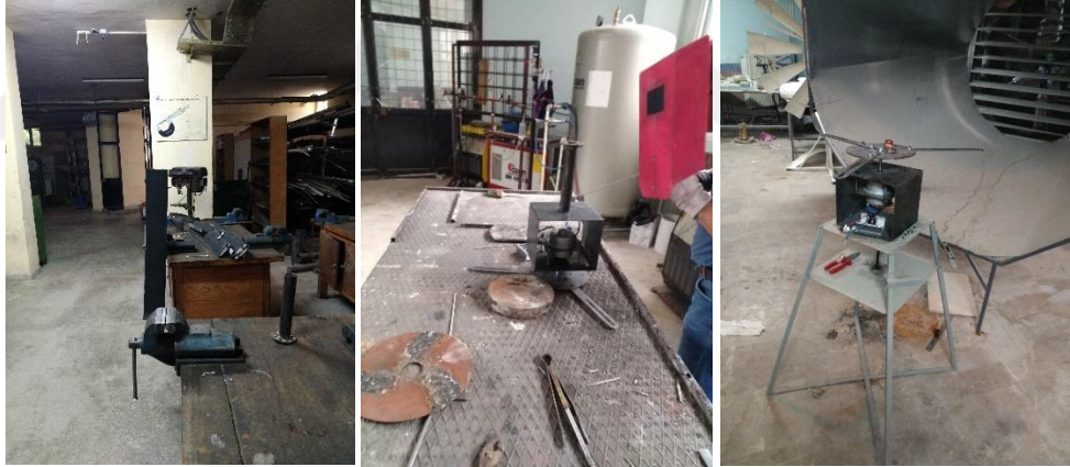
Şekil 3.30. Türbin montaj aşamaları
