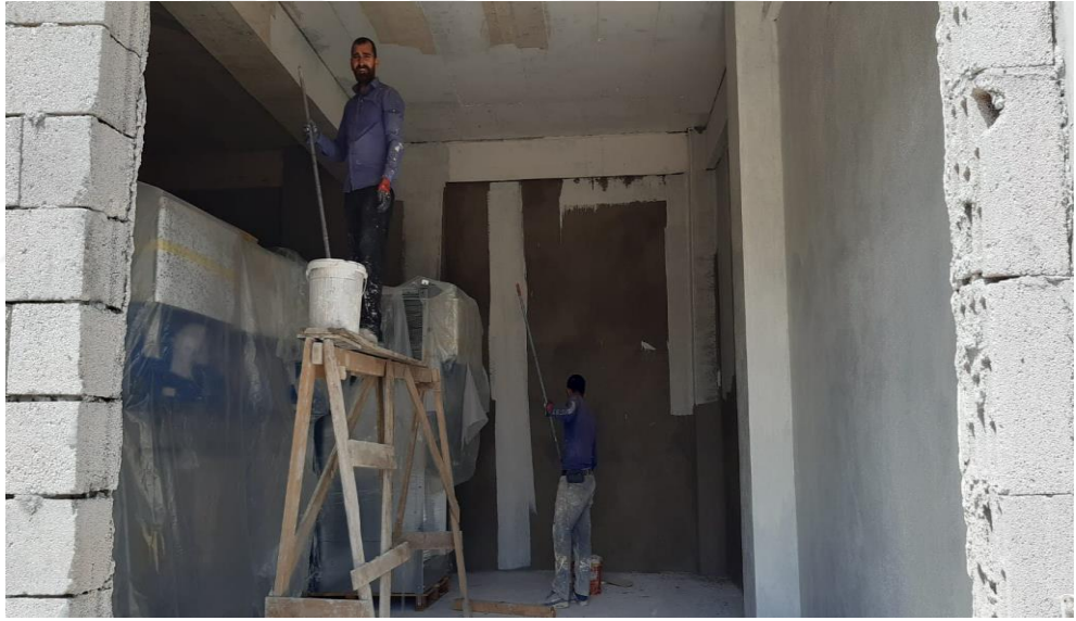
Şekil 22. Boya işleri çalışması
