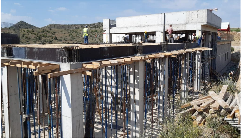
Şekil 20. Demir/Kalıp işleri çalışması
