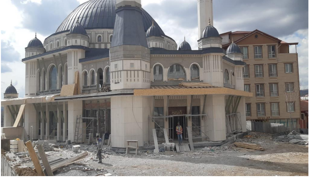
Şekil 23. Çatı işleri çalışması
