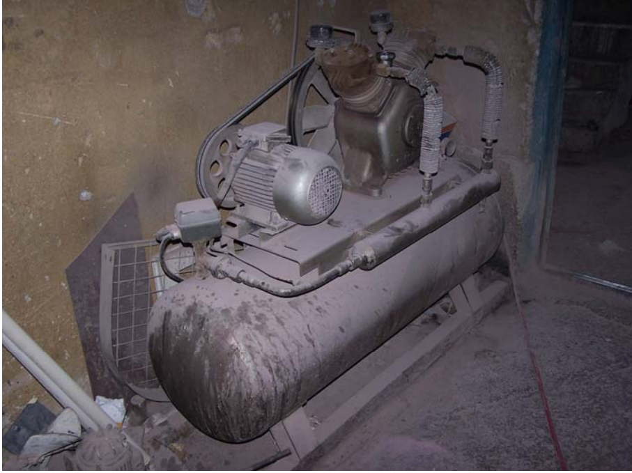
Resim 5. Kompresörün teçhiz edilmesinde hatalı bir örnek
