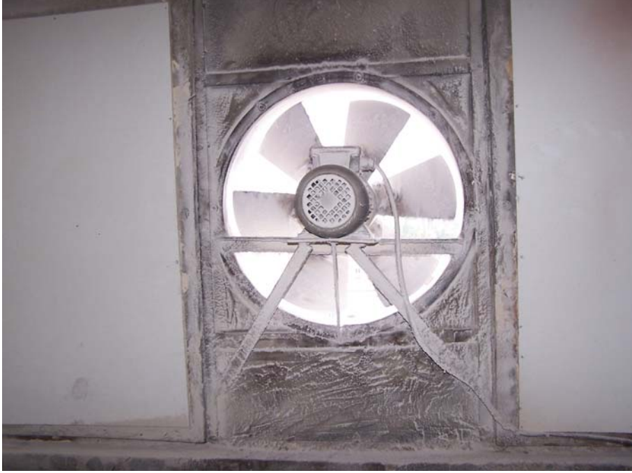
Resim 9. Pencere içerisine yerleştirilmiş aspiratör
