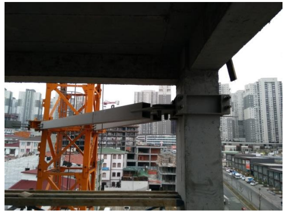
Şekil 2.23. Ankraj bağlantı kirişleriyle yapıdan destek almış kule vinç örnekleri
