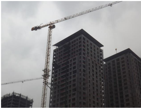
Şekil 2.23. Ankraj bağlantı kirişleriyle yapıdan destek almış kule vinç örnekleri
