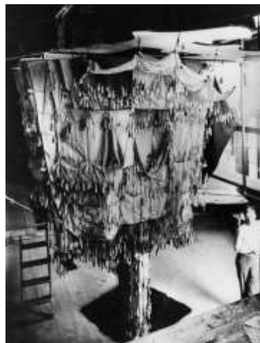
Figure 2.24: 1:10 hanging model for the Colònia Güell Chapel, Antoni Gaudí (Burry, 2016).
