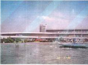
Yeşil alandan terminale bakış - önde havuz, arkada otobüs açık park alanları, yukarıda gelen ve giden yolcu katları peronları, en arkada Halkbankası Genel Müdürlüğü silüeti
