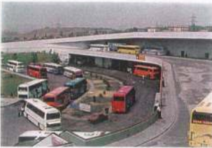
Gelen yolcu katı peronlarından, garajlar ve otobüs bakım-onarım birimleri katına bakış
