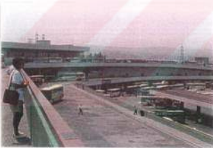
Terminal giden yolcu katı peronlarından aşağıya bakış - altta gelen yolcu katı peronları ve en altta akaryakıt istasyonları ve otobüs bakım-onarım alanları
