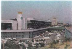
Konya Yolu'ndan terminal önüne bakış, araç park alanları ve Ankaray'dan terminale bağlanan köprü
