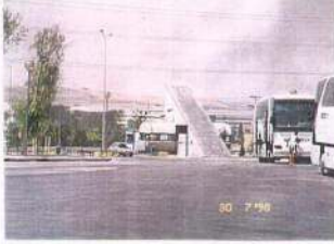
Söğütözü Caddesi tarafında terminal giriş ve çıkış kontrol kapısı
