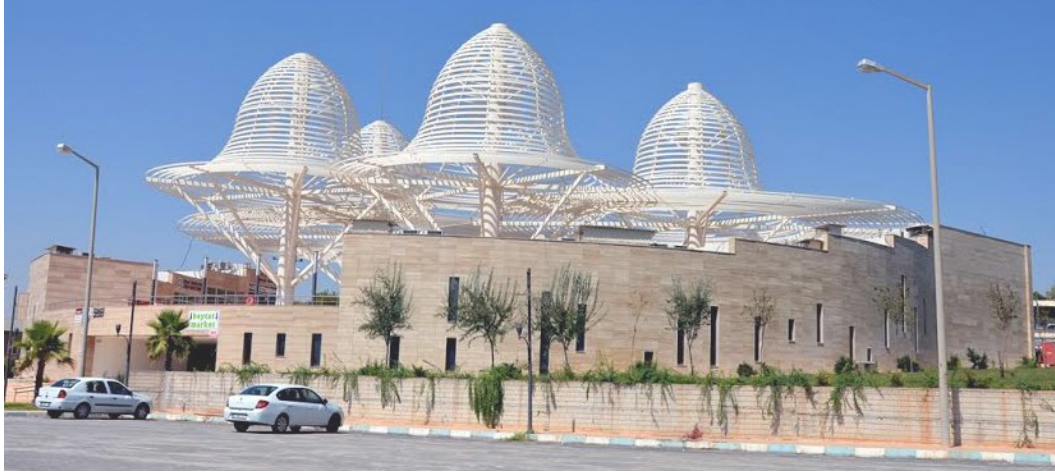
Şekil 5.18. Kademeli görünüme sahip kuzeydoğu cephesinin görseli (Hatice Kübra Öncel Arşivinden, 2024)
