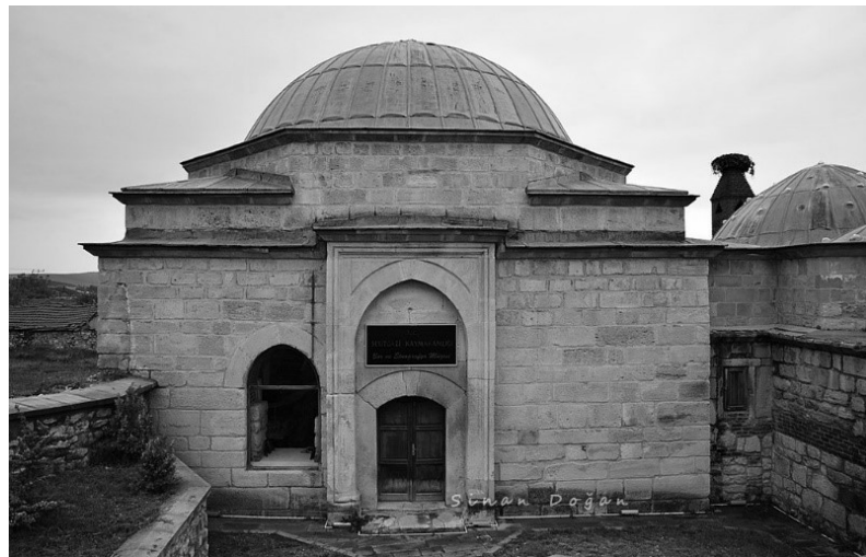
Şekil 2.33. Hamam yapıları, Selçuklu Hamamı [Url-5]
