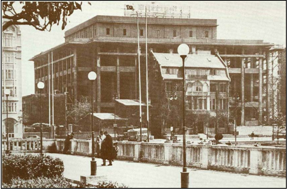
Resim 3.2. İlk projeye göre gerçekleştirilen kaba yapı (1953) [39]
