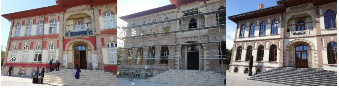
Şekil 3.19. Ön cephenin restorasyondan önceki hali 2017 (Kişisel Arşiv)
