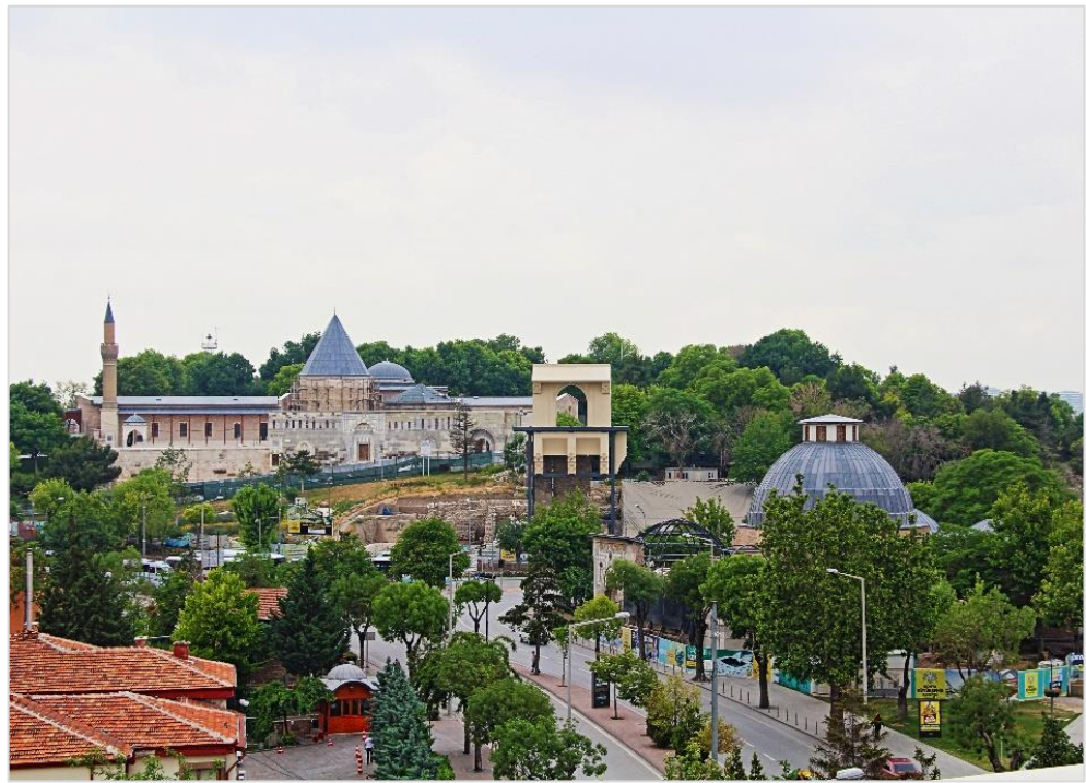
Şekil 3.8. Alaaddin Tepesi, köşk kalıntısı beton kabuk uygulaması ve Karatay Medresesi (URL-11) Şekil 3.9. Alaaddin Tepesi, köşk kalıntısı rekonstrüksiyon uygulaması ve Karatay Medresesi (Uz, 2017)
