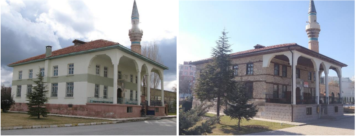
Şekil 3.37 Aslanlı Kışla Cami sol ve ön cephesi onarımdan önce 2012 (URL-23)
