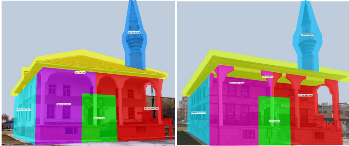
Şekil 3.40. Aslanlı Kışla Camii önce ve sonra fotoğrafları üzerinde belirlenen ilgi alanı bölgeleri
