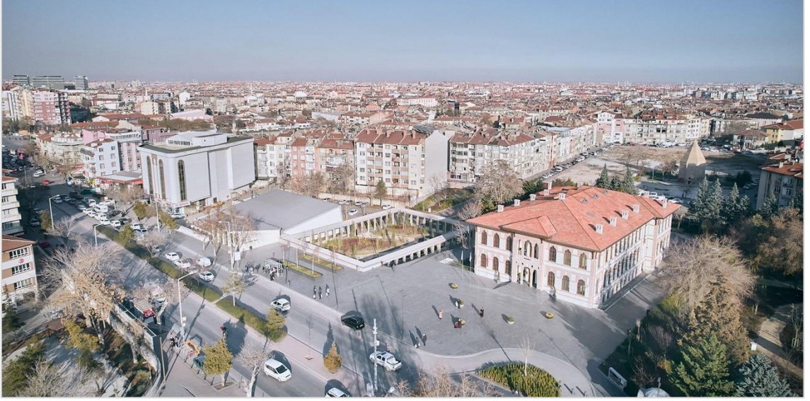
Şekil 3.17. Restorasyon sonrası yapının arka bölümü ve çevresi (URL-18)
