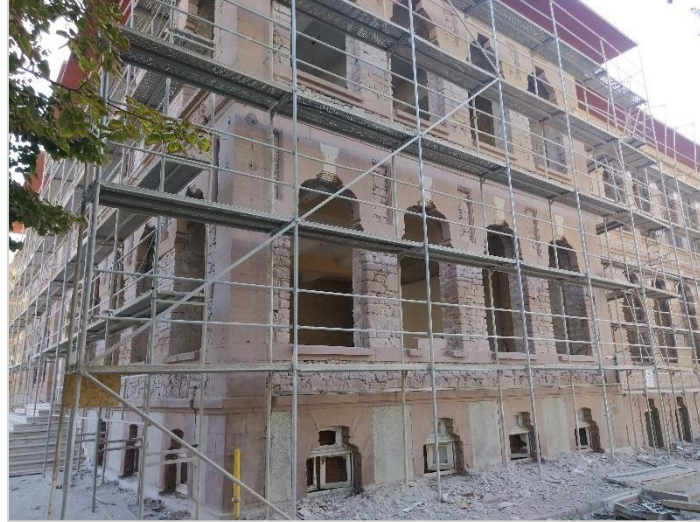
Şekil 3.18. Restorasyon sırasında raspa işlemi sonucu görünen cephe malzemeleri 2021 (Kişisel Arşiv)
