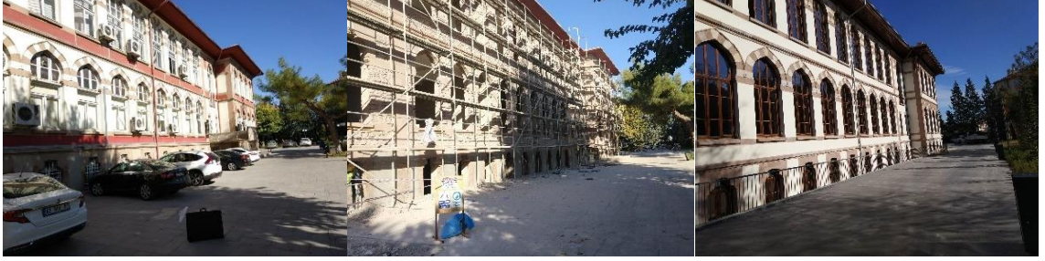
Şekil 3.22. Güney cephesinin restorasyondan önceki hali 2017 (Kişisel Arşiv)
