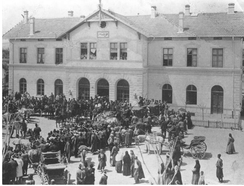
Şekil 3.25. 1904 yılı istasyon binası (URL-19)
