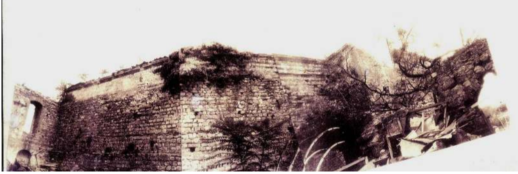
Resim 4.8. Revir binası duvarı [KMDB arşivinden, 2009].
