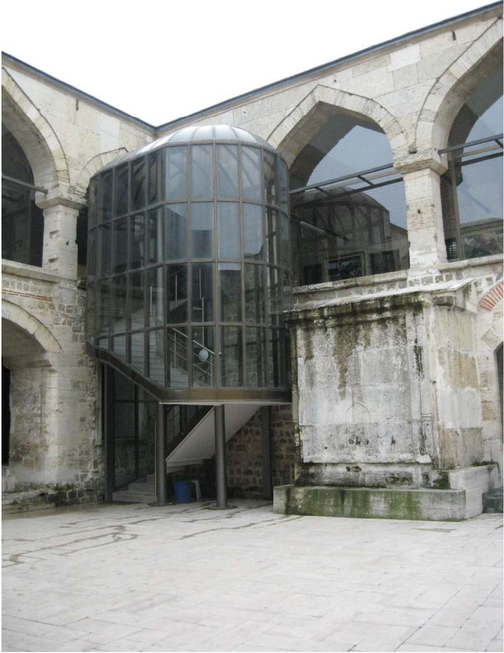
Resim 4.26. Avludan 1 inci kata ıkan cam kaplı merdiven [Seven arşivinden, 2009].
