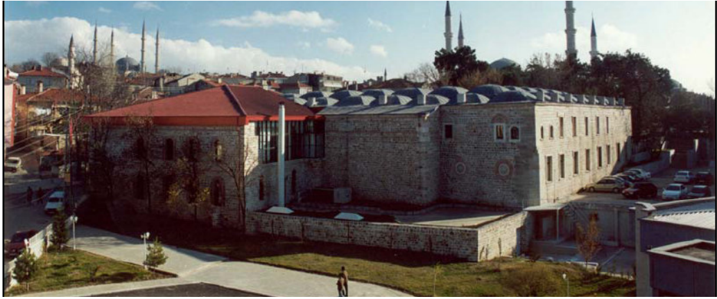
Resim 4.9. Edirne Deveci Han yeniden işlevlendirme sonrası görünüm [Yılmaz, 2006].
