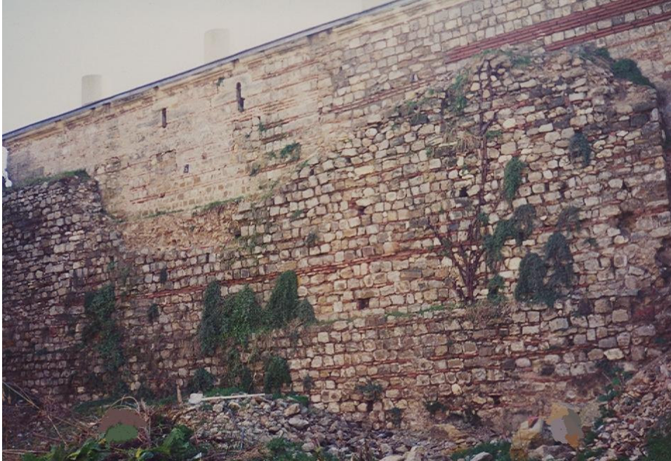
Resim 4.7. Revir binası duvarı [KMDB arşivinden, 2009].
