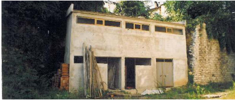
Resim 4.50. Ordu Çok Amaçlı Salon teknik binanın uygulama sırasındaki görünümü [KMDB arşivinden, 2010].
