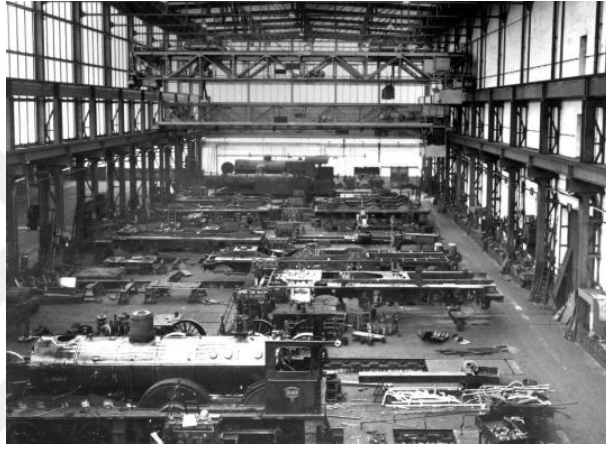
Şekil 4.30. Tilburg Lokomotif Atölyesi (URL-69)
