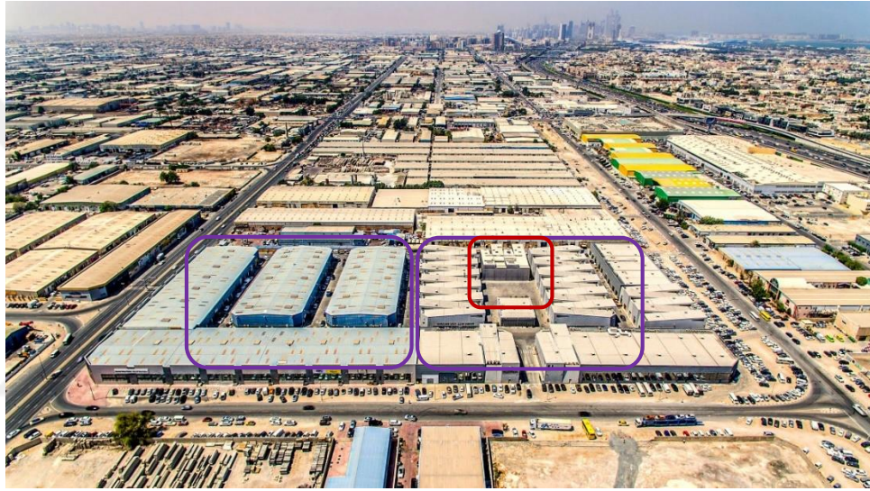
Şekil 4.17. Sol tarafta orijinal depolar, sağ tarafta ortada ise yenilenen yapı (URL-52)
