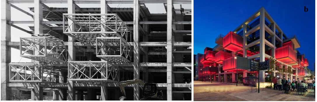
Şekil 4.42. İstanbul Resim ve Heykel Müzesi konteyner galeri a) Konteyner galerinin inşaat aşamasındaki dış görünüşü (URL-74) b) Konteyner galerinin tamamlandıktan sonraki dış görünüşü (URL-74)
