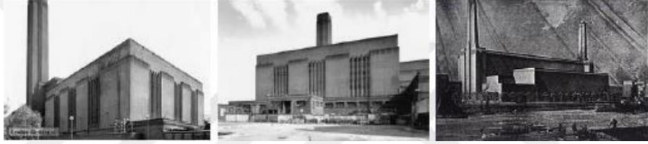
Şekil 4.1. Bankside Elektrik Santrali (Çetin, 2021)
