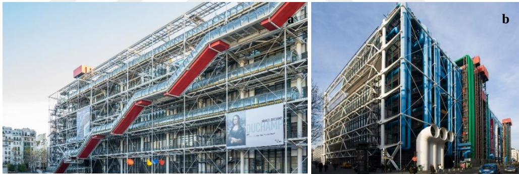
Şekil 2.21. Centre Pompidou sirkülasyon ve servis elemanları a) Ana cephedeki asansör ve merdivenler (URL-14) b) Tesisat elemanlarının bulunduğu cephe (URL-14)
