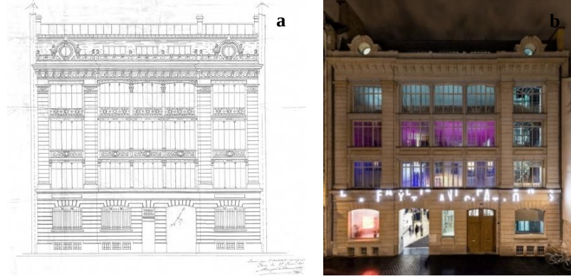
Şekil 4.24. Fondation Galeries Lafayette ön cephesi a) Eski ön cephe görünüşü (URL-60) b) Yeni ön cephe görünüşü (URL-61)
