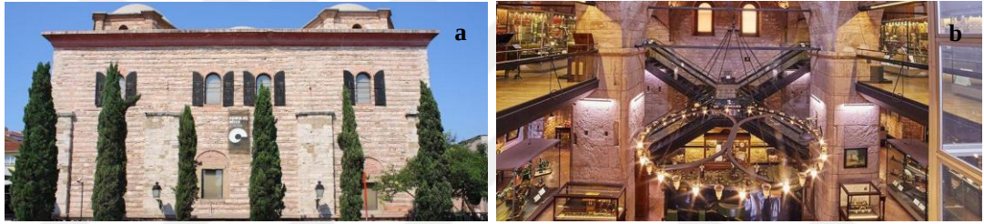
Şekil 3.15. Lengerhane Binası (Mustafa V. Koç Binası) a) Yeniden işlevlendirme sonrası müzenin dış görseli (URL-29) b) Yeniden işlevlendirme sonrası müzenin iç görseli (URL-29)
