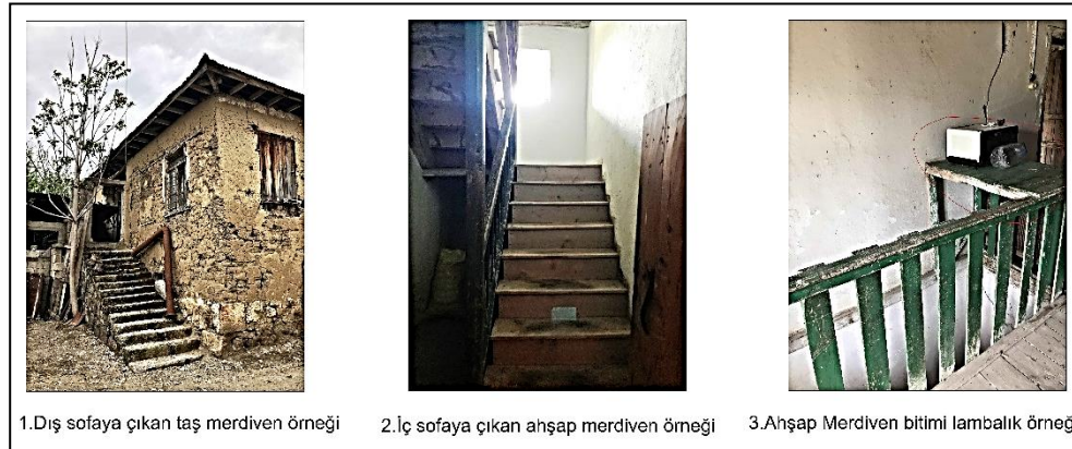
Şekil 6.11. Yörük Evinde Merdiven Detayı (Yazarın Arşivi)
