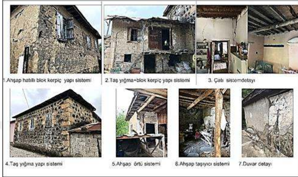
Şekil 6.13. Burhanlı Köyündeki Konutların Yapım Sistemleri ve Malzemeleri (Yazarın Arşivi)
