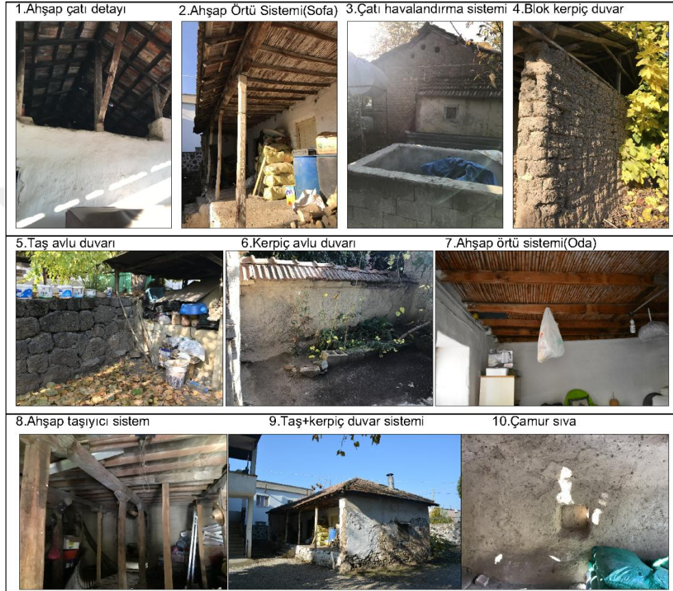
Şekil 6.47. Mustafabeyli Köyündeki Konutların Yapım Sistemleri ve Malzemeleri (Yazarın arşivi)
