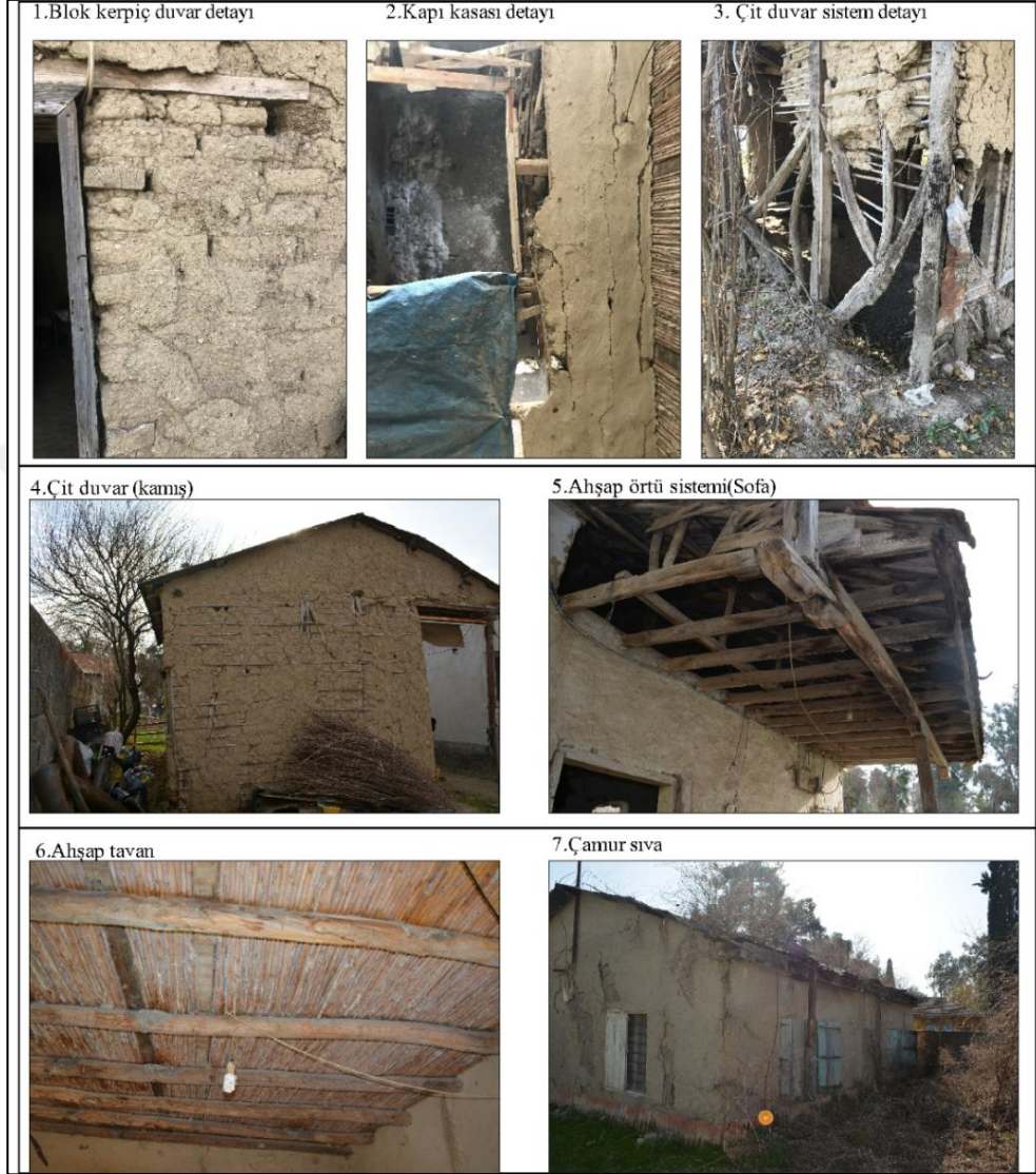
Şekil 6.57. Adapınar Köyündeki Konutların Yapım Sistemleri ve Malzemeleri (Yazarın arşivi)
