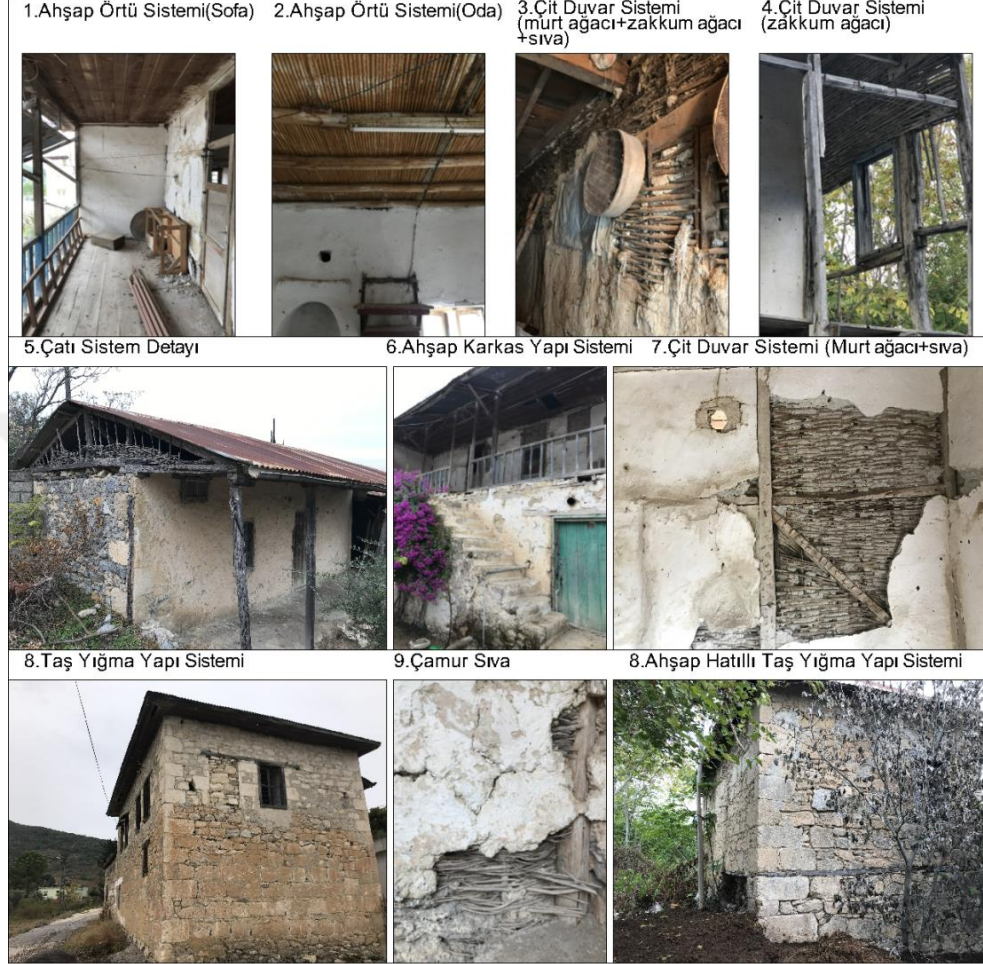
Şekil 6.25. Durhasandede Köyündeki Yapım Sistemleri ve Malzemeleri (Yazarın arşivi)
