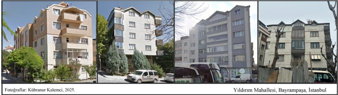
Şekil 4.2.3.2. 12: Geleneksel Detayların Modern Yapılarda Sürdürülmesi: Güvercinlik ve Eğimli Çatı Örnekleri.
