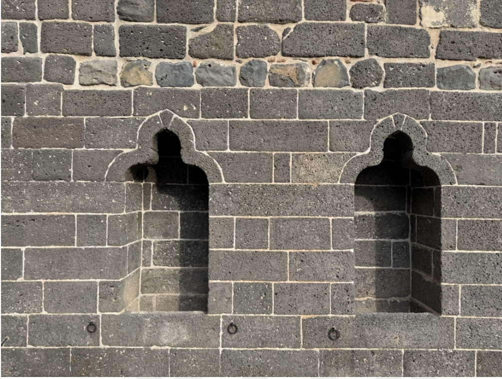
Görsel 17. Cemil Paşa Konağı duvar nişi ayrıntısı (Sevda Tuğrul, 2024)
